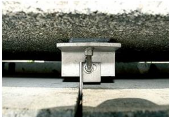
Foto 4 - Colocação da placa de rocha
