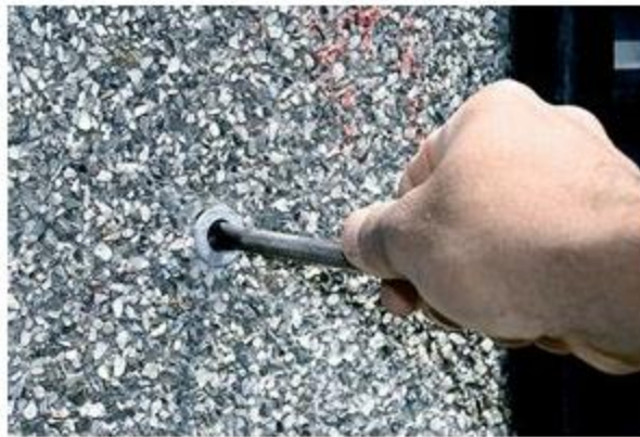
Foto 2 - Colocação do chumbador
