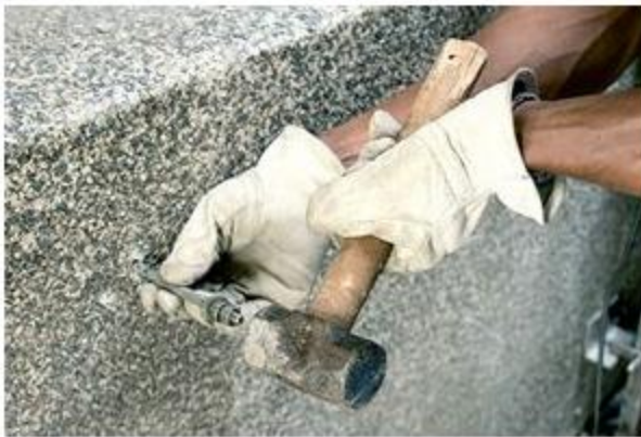
Foto 1 - Furo no concreto e limpeza do furo
