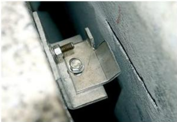
Foto 3 - Colocação do inserto com chumbador de expansão
