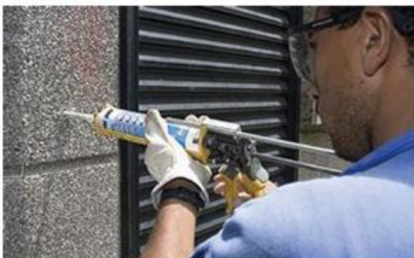
Foto 3 - Colocação do inserto com chumbador de expansão
