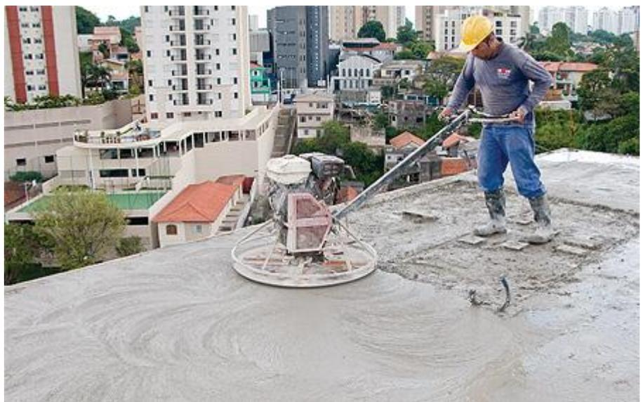
Nos edifícios de apartamentos com áreas menores de 100 m<sup>2</sup>, a laje zero com 10 cm de espessura, principalmente nas estruturas de alvenaria, basta para garantir o desempenho, desde que observados os cuidados de execução
