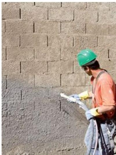
**Passo 2** - Com a pistola do equipamento, comece a aplicar o chapisco por toda a superfície da alvenaria, que servirá para formar uma ponte de aderência entre o substrato e a argamassa.
