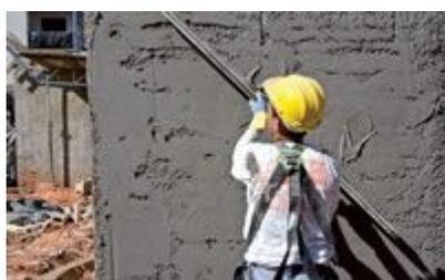
**Passo 6** - Com uma régua metálica dê início ao sarrafeamento, uniformizando a massa.
