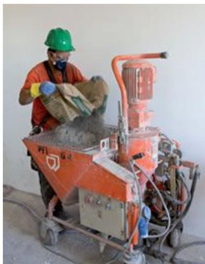
**Passo 1** - Abra a embalagem de argamassa e coloque no local de abastecimento do equipamento de projeção. Ligue o equipamento, acerte a pressão e a quantidade de água, de acordo com as instruções do fabricante.
