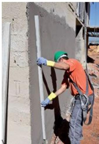
**Passo 9** - Use de novo a régua metálica para regularizar e finalizar a superfície.
