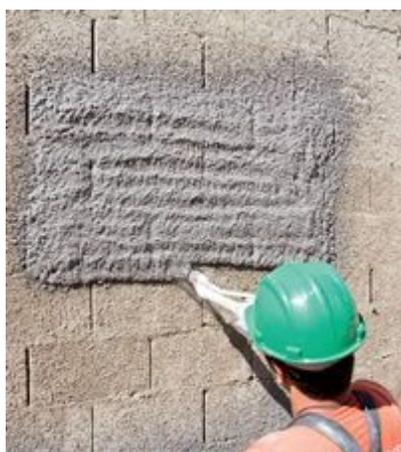
**Passo 3** - Antes de começar a projeção, para regulagem do equipamento, posicione a pistola a 90° em relação à alvenaria, a uma distância de 10 cm. Inicie então a projeção dos cordões de argamassa, de acordo com a espessura da camada recomendada no projeto. Cubra um trecho (pano) de cerca de 1,20 m x 2 m.
