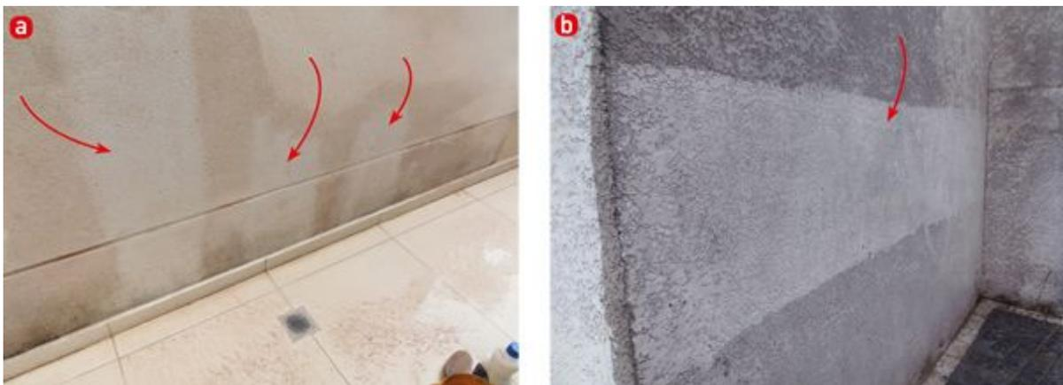
**Figura 1** - Trechos de limpezas executadas mecanicamente com água pressurizada e solução de hipoclorito nas cidades de Indaiatuba (a) e São Paulo (b)
