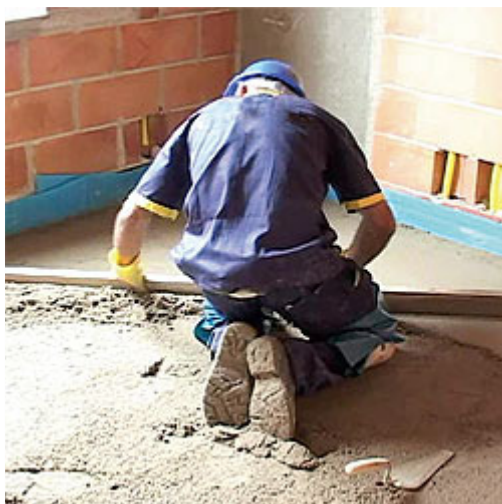
Foto 16 - Sarrafeamento da camada de contrapiso entre duas mestras
