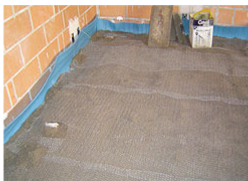
Foto 10 - Aplicação de armadura galvanizada do tipo viveiro sobre a primeira camada de argamassa de contrapiso. Observa-se o corte da tela na região das taliscas
