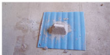
Fotos 4, 5 e 6 - Taliscas para o contrapiso flutuante aplicado sobre material isolante acústico
