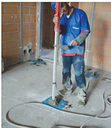
Fotos 4, 5 e 6 - Taliscas para o contrapiso flutuante aplicado sobre material isolante acústico
