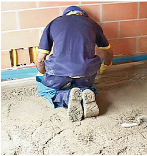
Foto 15 - Execução das mestras
