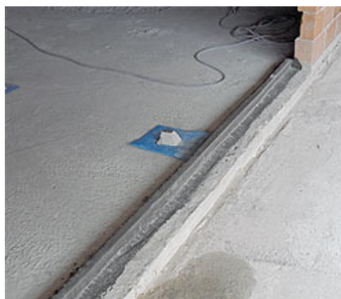
Foto 8 - Pré-moldado posicionado entre áreas de sala (contrapiso flutuante) e cozinha (contrapiso aderido)
