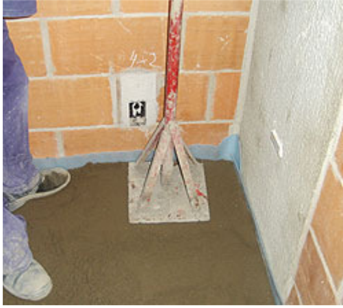
Foto 14 - Compactação do contrapiso utilizando-se soquete de base 30 x 30 cm e massa de 7 a 10 kg
