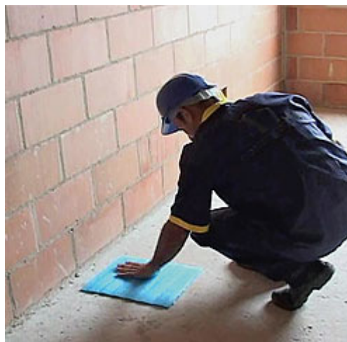
Foto 3 - Material acústico previamente colado à laje para receber a talisca
