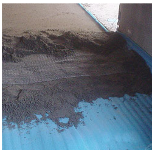
Foto 13 - Exemplo de execução progressiva do contrapiso flutuante
