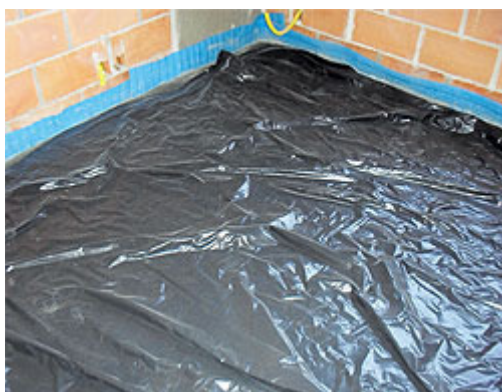
Foto 18 - Proteção da superfície do contrapiso para melhorar as condições de secagem
