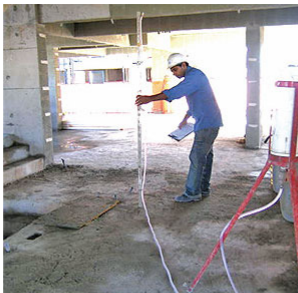
Foto 1 - Mapeamento do nivelamento e das características geométricas da laje
