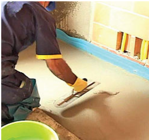
Foto 17 - Acabamento alisado empregando-se desempenadeira de aço após uso de desempenadeira de madeira
