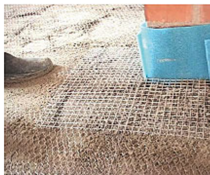
Figura 4 e Foto 12 - Utilização de tela de alvenaria em cantos convexos para minimizar riscos de fissuras no contrapiso flutuante
