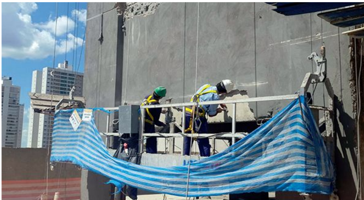
Trabalho de recuperação de fachada argamassada que apresentou problemas devido a deficiências no preparo da base
