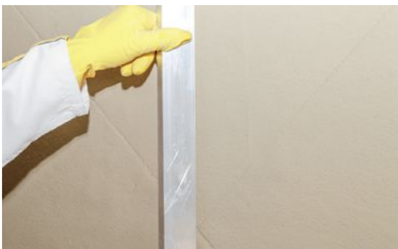
Figura 4 - No acabamento do tipo raspado deve-se proceder a raspagem da superfície com o perfil I
