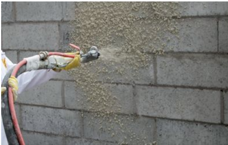
Figura 3 - Detalhe da aplicação com projetor mecânico
