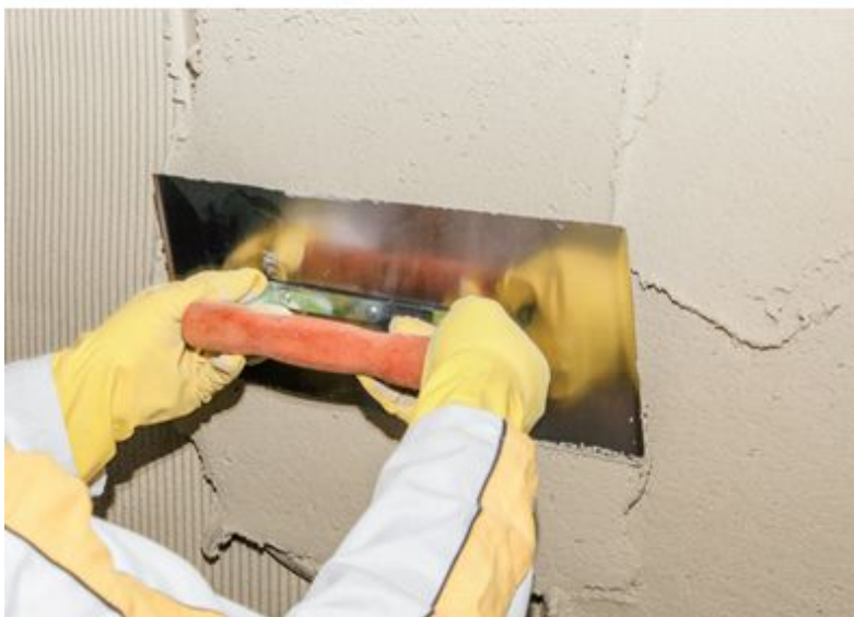
Figura 5 - Finalização da aplicação no acabamento travertino
