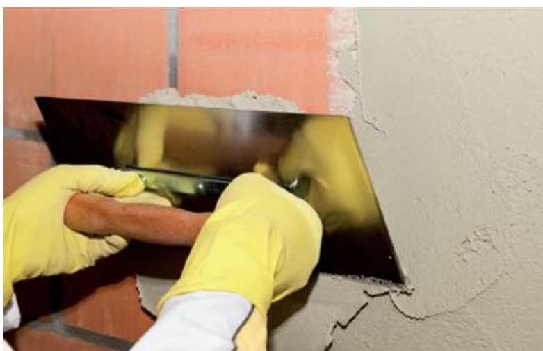
Figura 2 - Aplicação da primeira camada de argamassa com 5 mm
