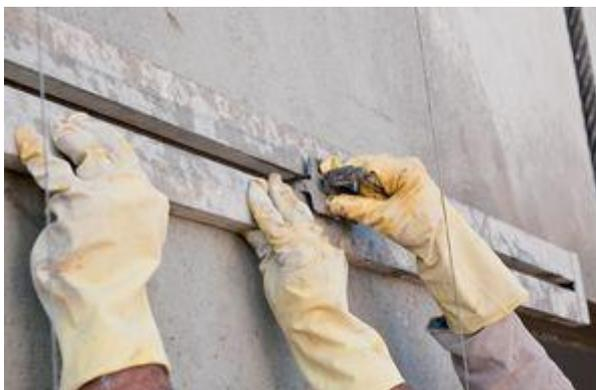
**Passo 13.** As juntas de trabalho devem ser executadas a cada pavimento logo após o desempeno, com profundidade igual à metade da espessura do emboço e largura de 1,5 cm a 2 cm. No fundo da junta, a largura deve ser de, no mínimo, 1 cm. É importante comprimir o fundo da junta com o frisador metálico para que a argamassa não fique porosa e não permita a entrada de água e o acúmulo de sujeira.
