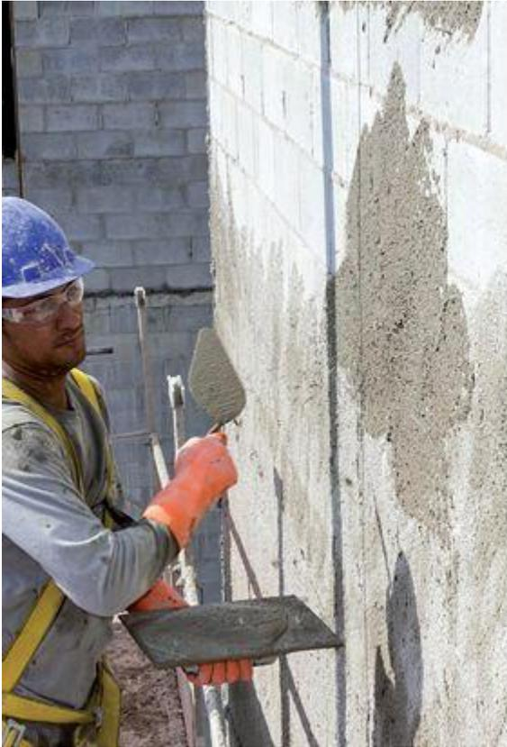
**Passo 1.** Com a base limpa, aplique o chapisco com a colher de pedreiro a partir da laje, de cima para baixo. A espessura dessa camada varia entre 3 mm e 5 mm. Espere curar por três dias.
