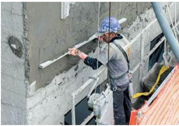
**Passo 9.** O sarrafeamento deve ser feito de baixo para cima, obedecendo às mestras, e não pode ser feito imediatamente após o lançamento da argamassa. Para avaliar o ponto de sarrafeamento, pressione a argamassa com os dedos. O ponto ideal é quando os dedos não penetram na camada, permanecendo praticamente limpos, mas deformando levemente a superfície.
