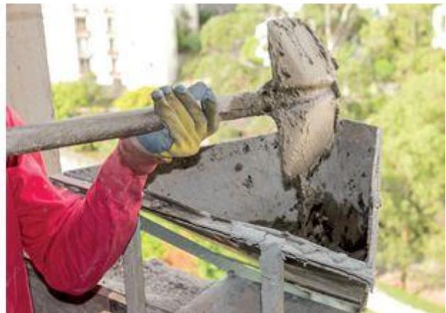
**Passo 6.** Os balancins devem ser abastecidos periodicamente, de forma que o tempo de vida útil da mistura, de cerca de duas horas, não se esgote.
