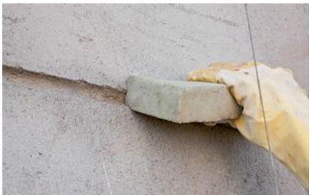
**Passo 14.** Depois da retirada da régua dupla, as rebarbas de argamassa remanescentes devem ser eliminadas com um feltro.
