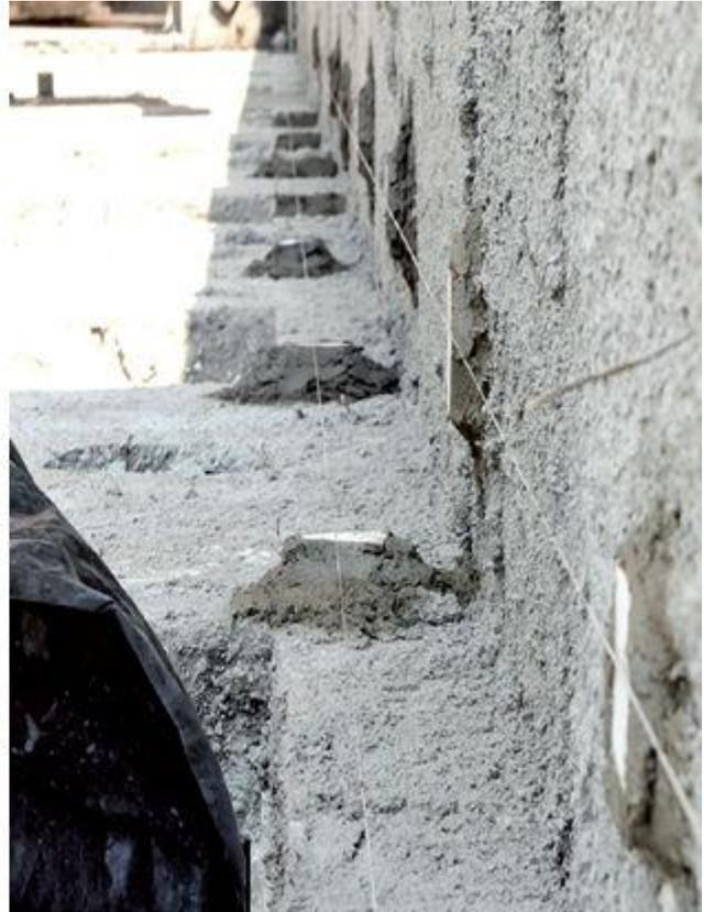
**Passo 2.** A cada 1,5 m ou 1,8 m, estique um arame ao longo de toda a altura da fachada até o térreo. Esses arames, que devem ficar a cerca de 2 cm ou 3 cm da alvenaria, servem para garantir a planicidade e o prumo durante a execução do emboço.
