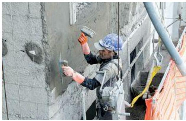
**Passo 10.** Umedeça a argamassa já aplicada com a broxa e alise a superfície com a desempenadeira para dar o acabamento.
