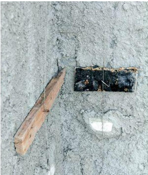
**Passo 3.** Estique arames também nas quinas e cantos internos (um em cada face) com espaçamento de 10 cm a 15 cm da aresta, nas ombreiras das janelas, nos eixos de juntas estruturais e em outros pontos que exijam precisão.
