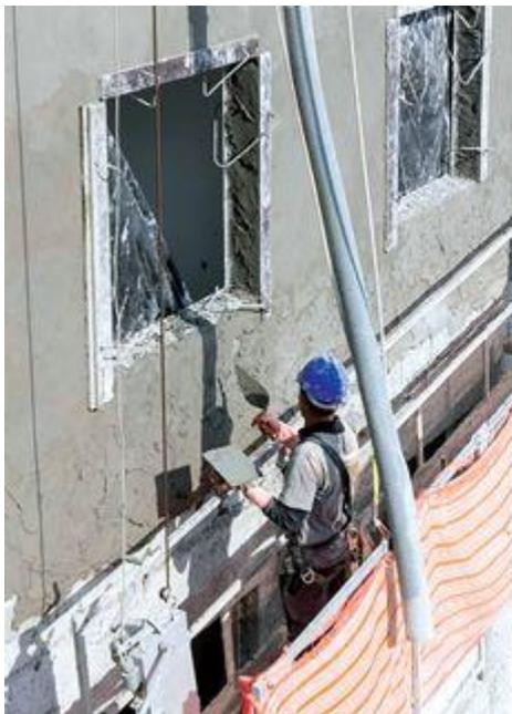
**Passo 7.** Inicie o emboço executando as mestras entre as taliscas com faixas de argamassa de cerca de 15 cm de largura. Depois, lance a argamassa obedecendo à espessura determinada pelas taliscas.
