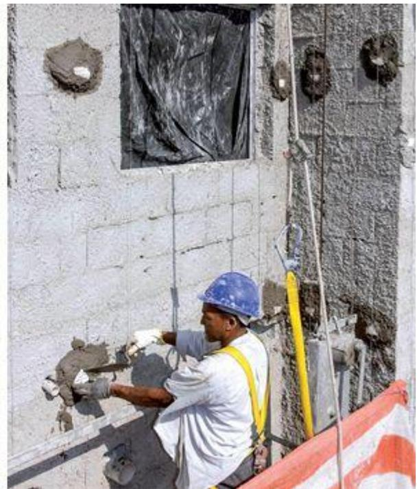
**Passo 4.** Para determinar a espessura da camada de emboço, assente taliscas ao longo dos arames de fachada, usando a mesma argamassa que será utilizada no revestimento. O mesmo vale para as proximidades das quinas e das ombreiras das janelas.
