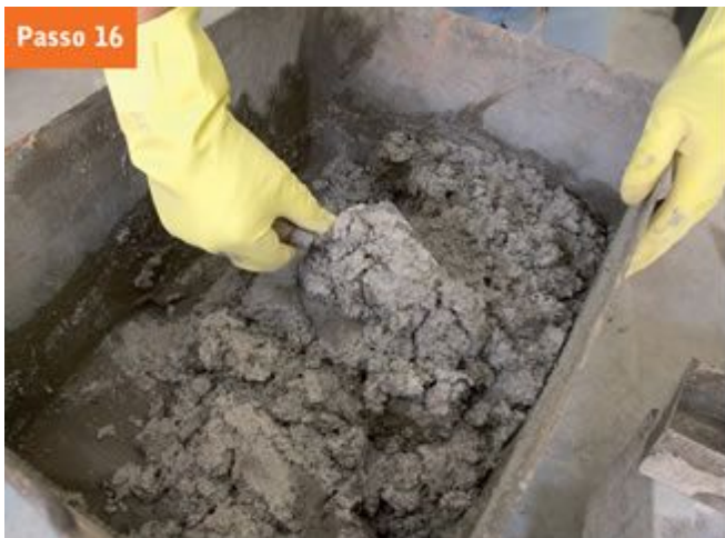
Passo 16 Misture a argamassa com água na proporção indicada pelo fabricante, até formar uma pasta homogênea.
