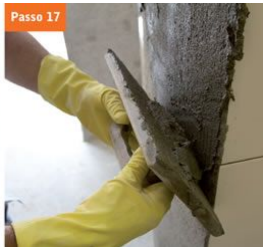
Passo 17 Umedeça a superfície que receberá a argamassa de reboco e aplique-a com auxílio da desempenadeira.
