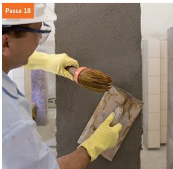
Passo 18 Com a broxa, aplique mais água na superfície e alise a argamassa, cobrindo os buracos.
