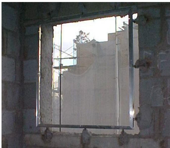
Figura 11: Fixação do contramarco chumbado com grapa.
