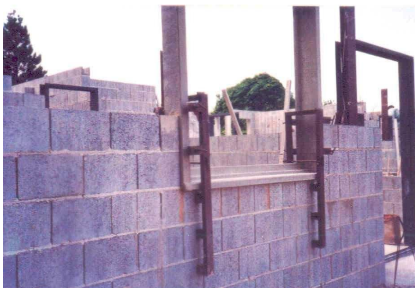
Figura 12: Contramarcos ou marcos assentados durante a elevação da parede.
