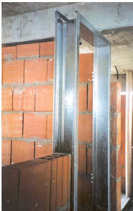
Figura 13: Contramarcos ou marcos assentados durante a elevação da parede.
