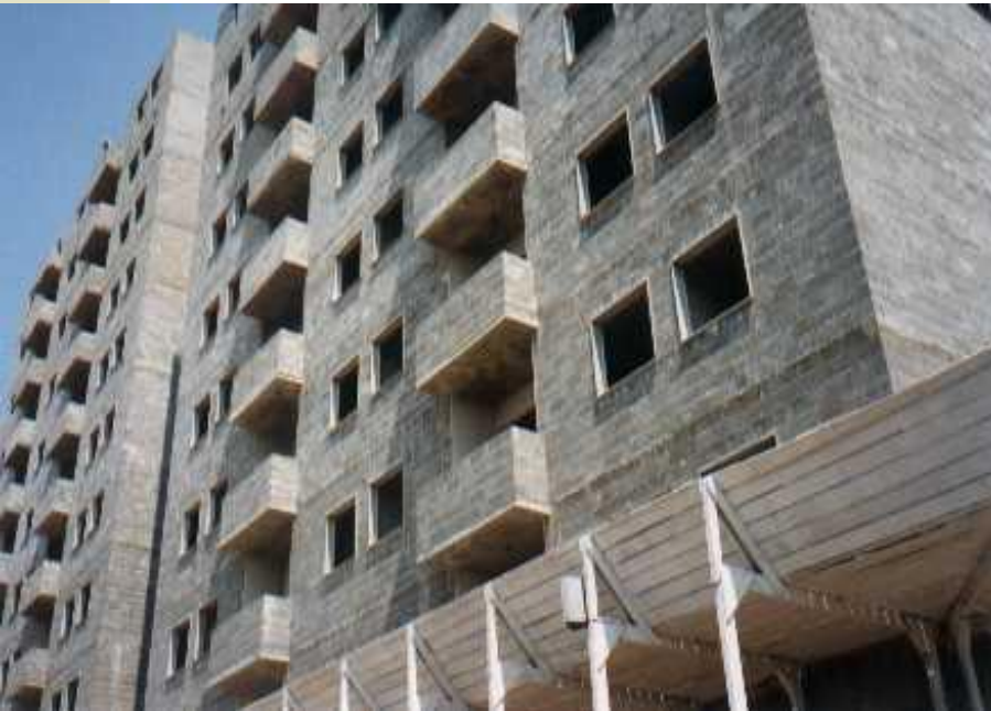
Bloco de concreto
