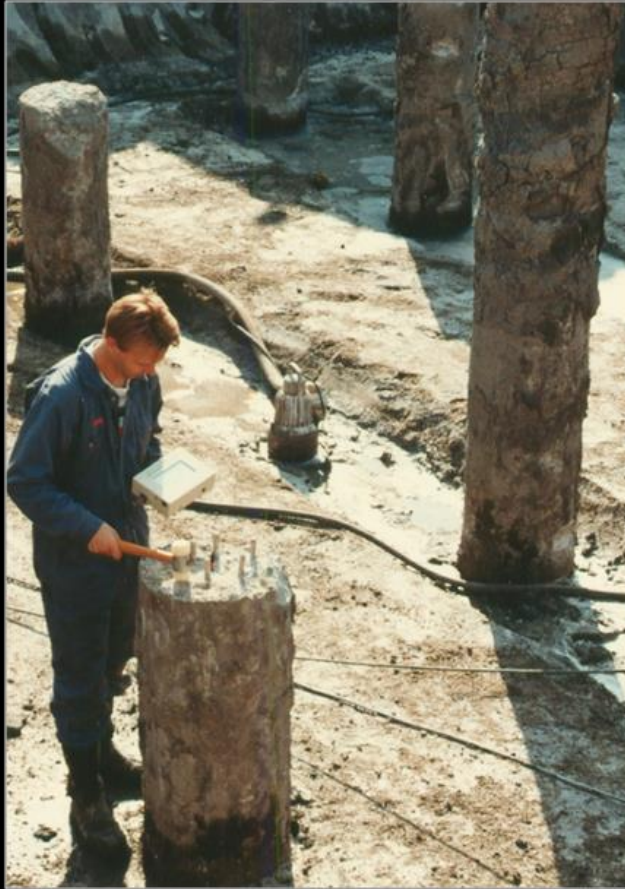
Estaca com sinal de anomalia
