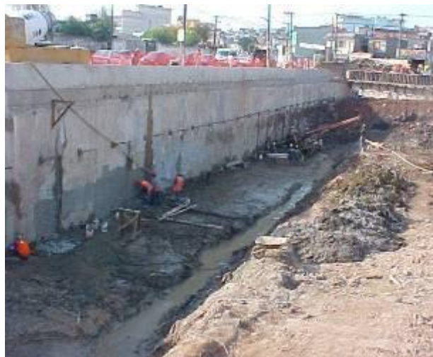
Figura 6.4 - Parede diafragma.
