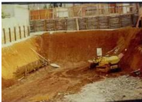
Figura 5.1 – Realização de escavação de um subsolo com emprego de pá carregadeira.
