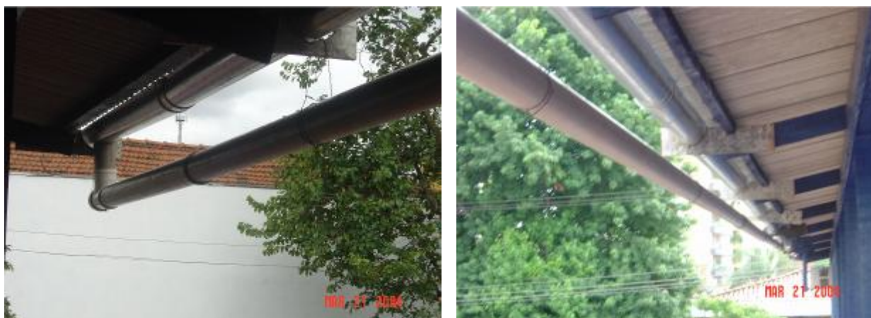
Figura 2.5 – Ilustração da captação de água pluvial para reuso durante a obra.
