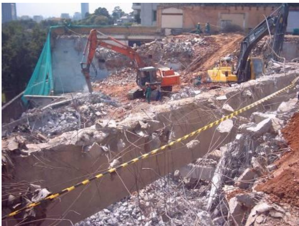
Figura 4.4 – Resíduo gerado no serviço de demolição, sendo retirado com auxílio de retroescavadeiras.
