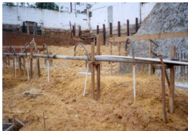
Figura 7.2 – Ponteiras filtrantes.
