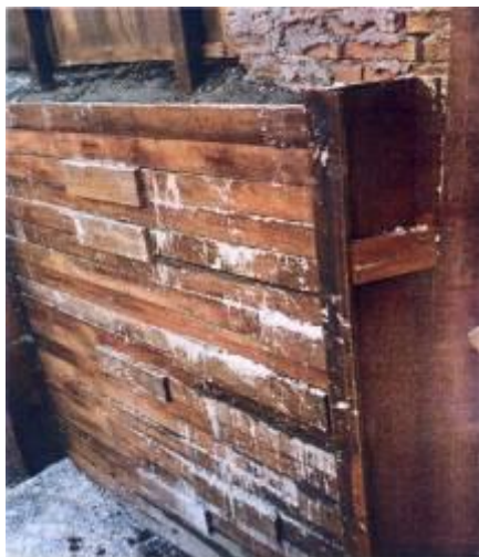
Figura 6.3 – Perfis metálicos + pranchões de madeira.
