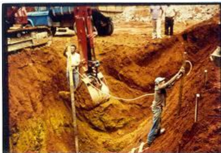
Figura 5.5 – Cota de fundo de escavação.
