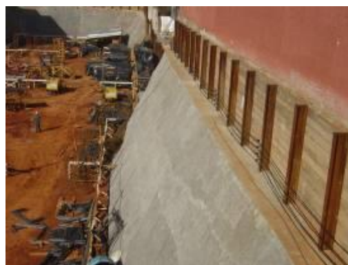
Figura 6.2 - Taludes associados a perfis metálicos + pranchões de madeira.
