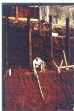
Figura 5.11 – Verificação da inclinação do talude
