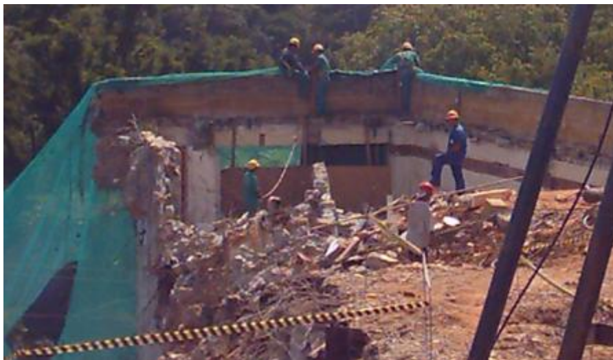
Figura 4.1 - Segurança dos operários durante as operações de demolição.
