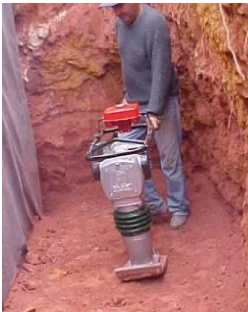
Figura 5.6 – Equipamento para compactação manual usualmente denominado “sapo mecânico”.
