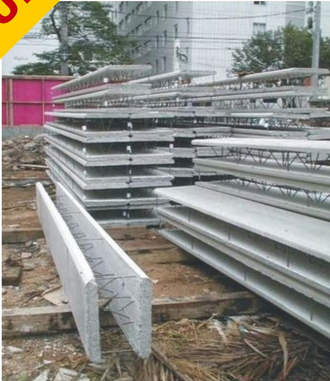
**PRANCHÃO PRÉ-FABRICADO DE CONCRETO**
