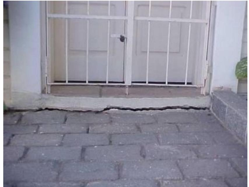
Trinca no encontro piso externo-piso interno
