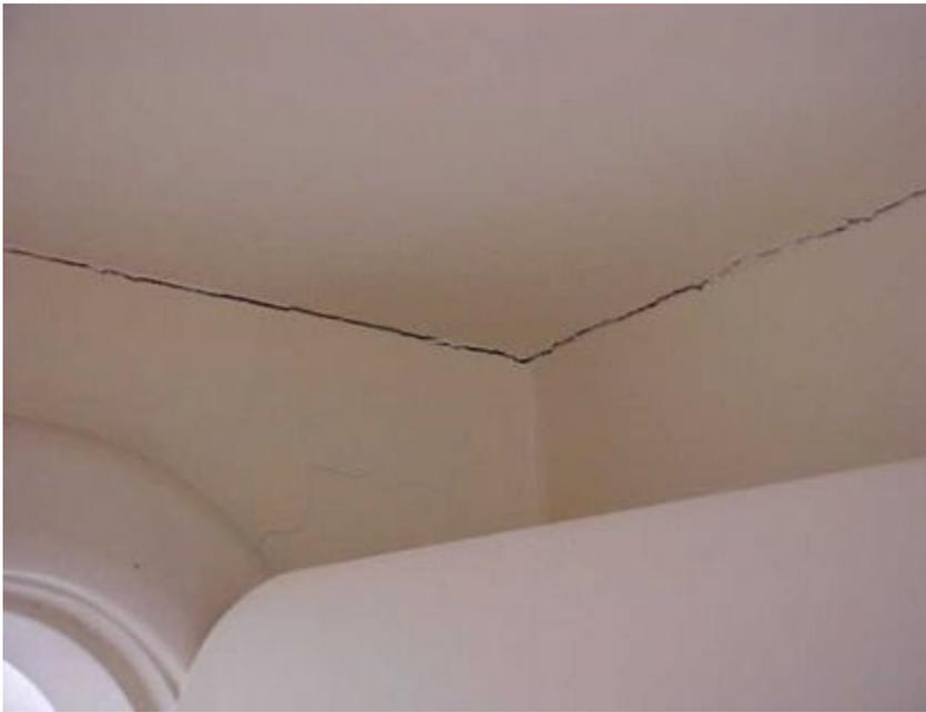
Trinca no encontro piso-parede
