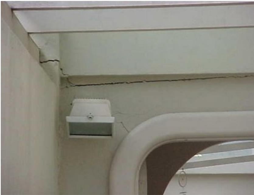
Trinca no encontro viga-parede
