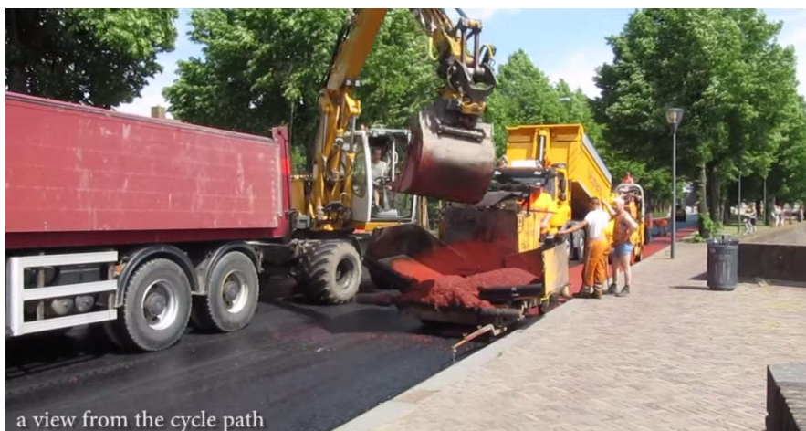
Figura 9-6 - Pavimentação de ciclovia na Holanda com asfalto já pigmentado [104]
