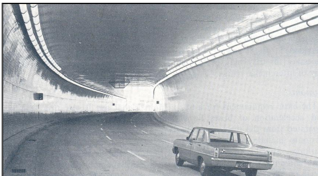
Figura 110 – Túnel de três faixas de sentido único
