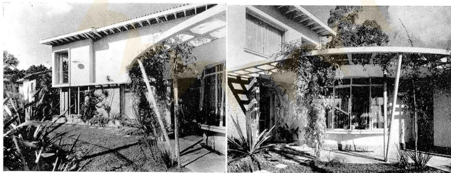
VISTA PARCIAL DA FACHADA
