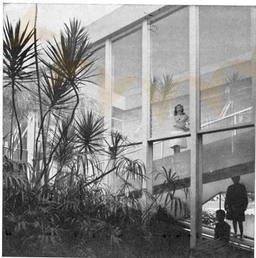
Dois aspectos do jardim interno. Na foto de baixo nota-se o nível das 3 rampas: a que se dirige à sala de estar, a de acesso para o estúdio e a superior, que dá para os dormitórios.
