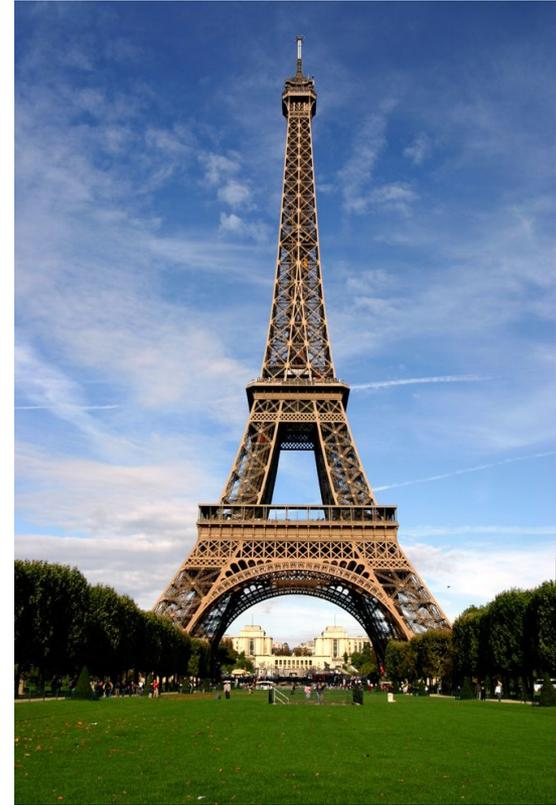
A Torre Eiffel foi construída com ferro pudlado
