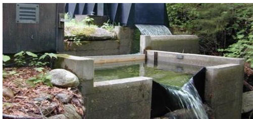
Vertedor triangular de soleira delgada
