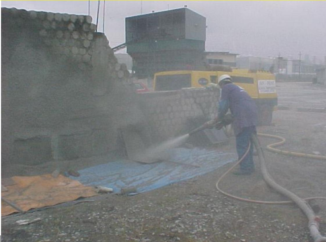
Compressor de ar com capacidade de  $10\text{m}^3$  por minuto (360PCM).
