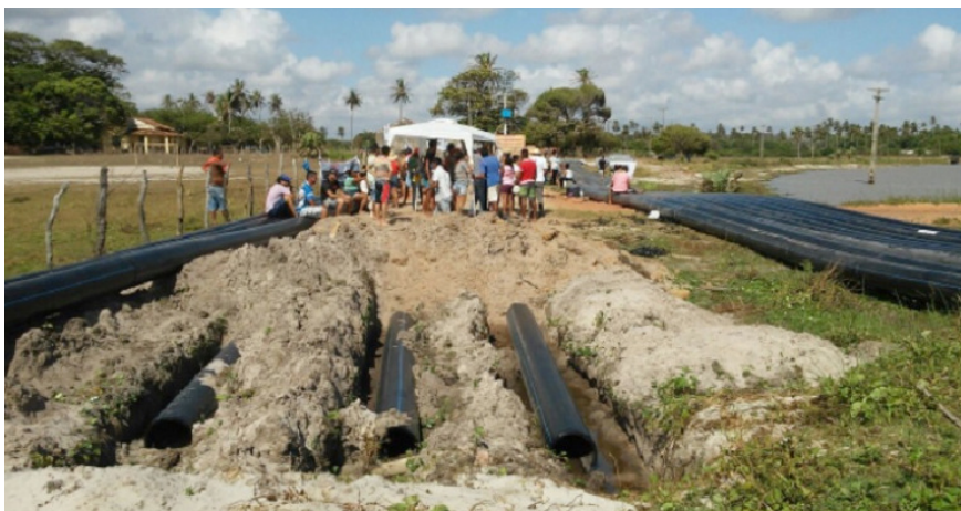
Foto 1 – Comunidades montam barracas e tendas nas extensões do canteiro de obras que pretende retirar água do Lagamar do Cauípe e convidam mais pessoas a permanecerem resistindo
