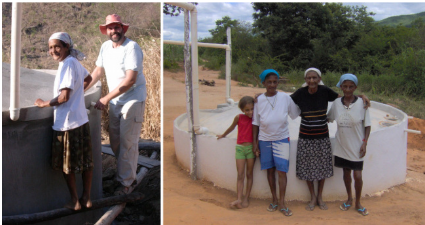
Fotos 13 e 14 – Comunidade da Mutuca de Cima, município de Virgem da Lapa. Caixa de captação d’água de chuva aprimorada pelo Gesta (2006)
