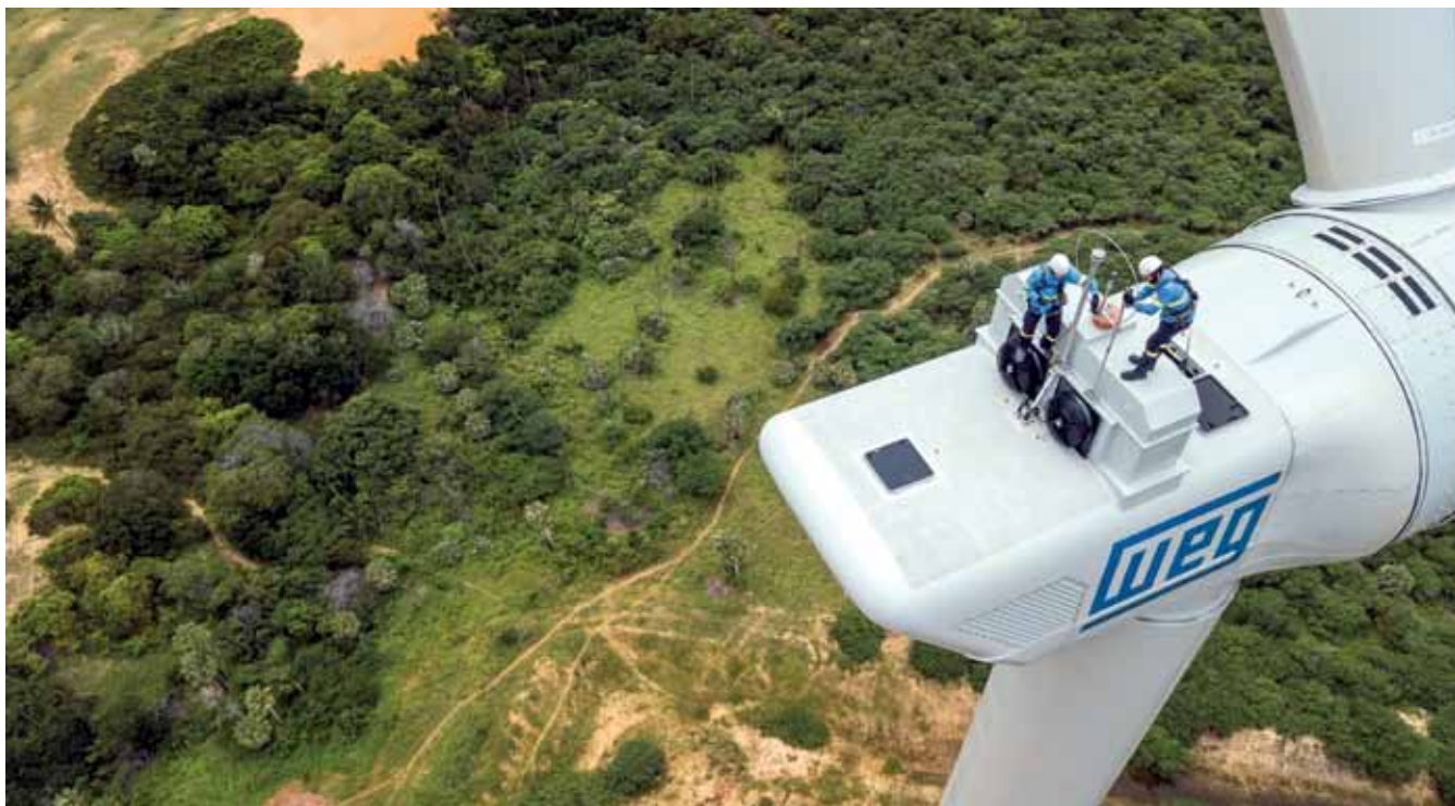
Técnicos fazem a manutenção de aerogerador da WEG instalado no Complexo Eólico Cutia, em São Bento do Norte, no Rio Grande do Norte
