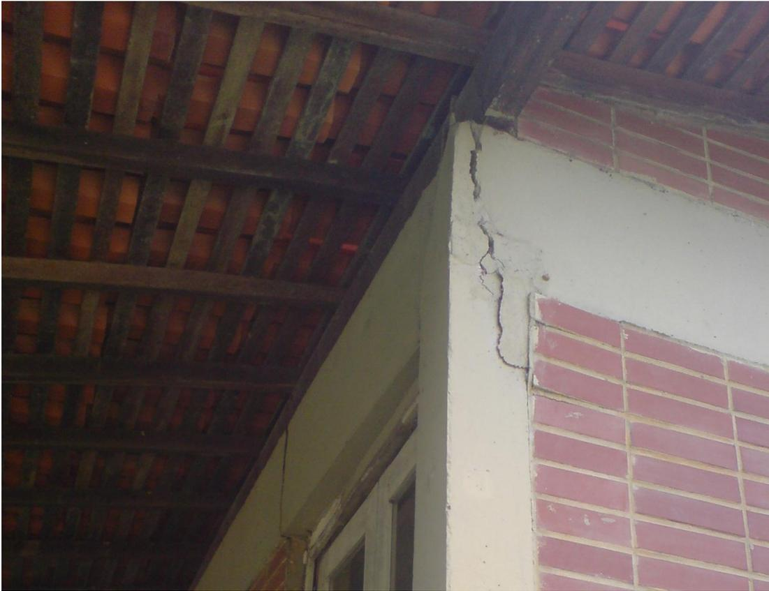
**Figura 5** – Escorregamento da armadura no apoio de uma viga – observar superfície de ruptura no concreto e esmagamento da alvenaria adjacente ao apoio, caracterizando transferência da carga que deveria ir para o pilar.
