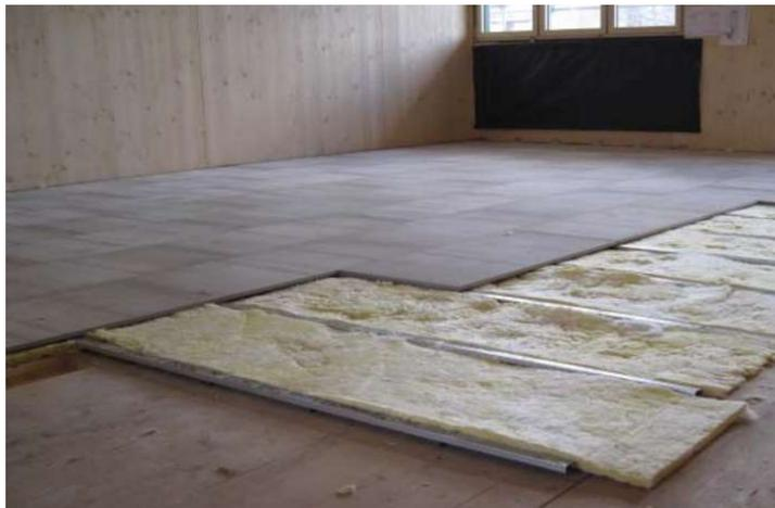
Piso flutuante com lã de vidro durante instalação.
