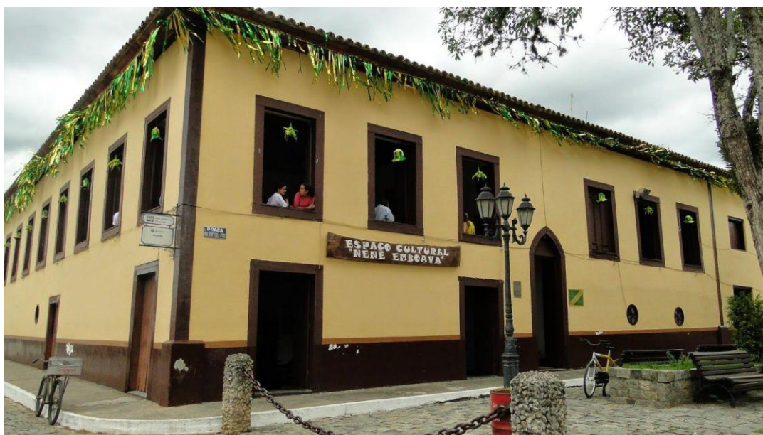
Figura 2 - Vista da fachada do Espaço Cultural Nenê Emboava
