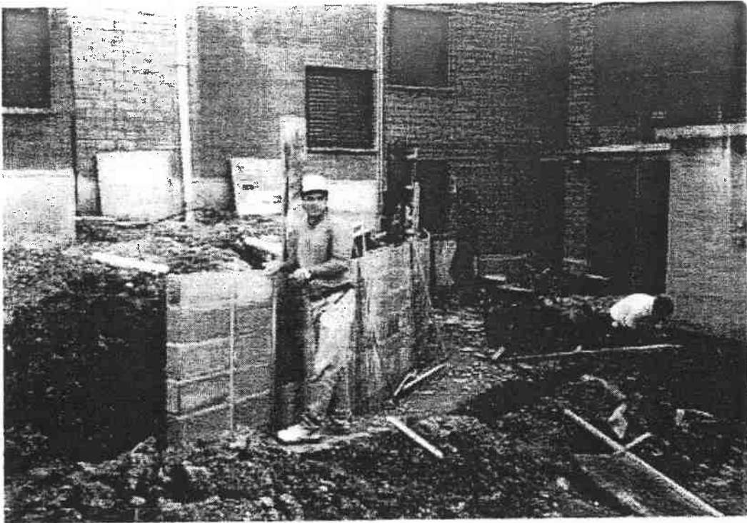
Execução do muro de armo
