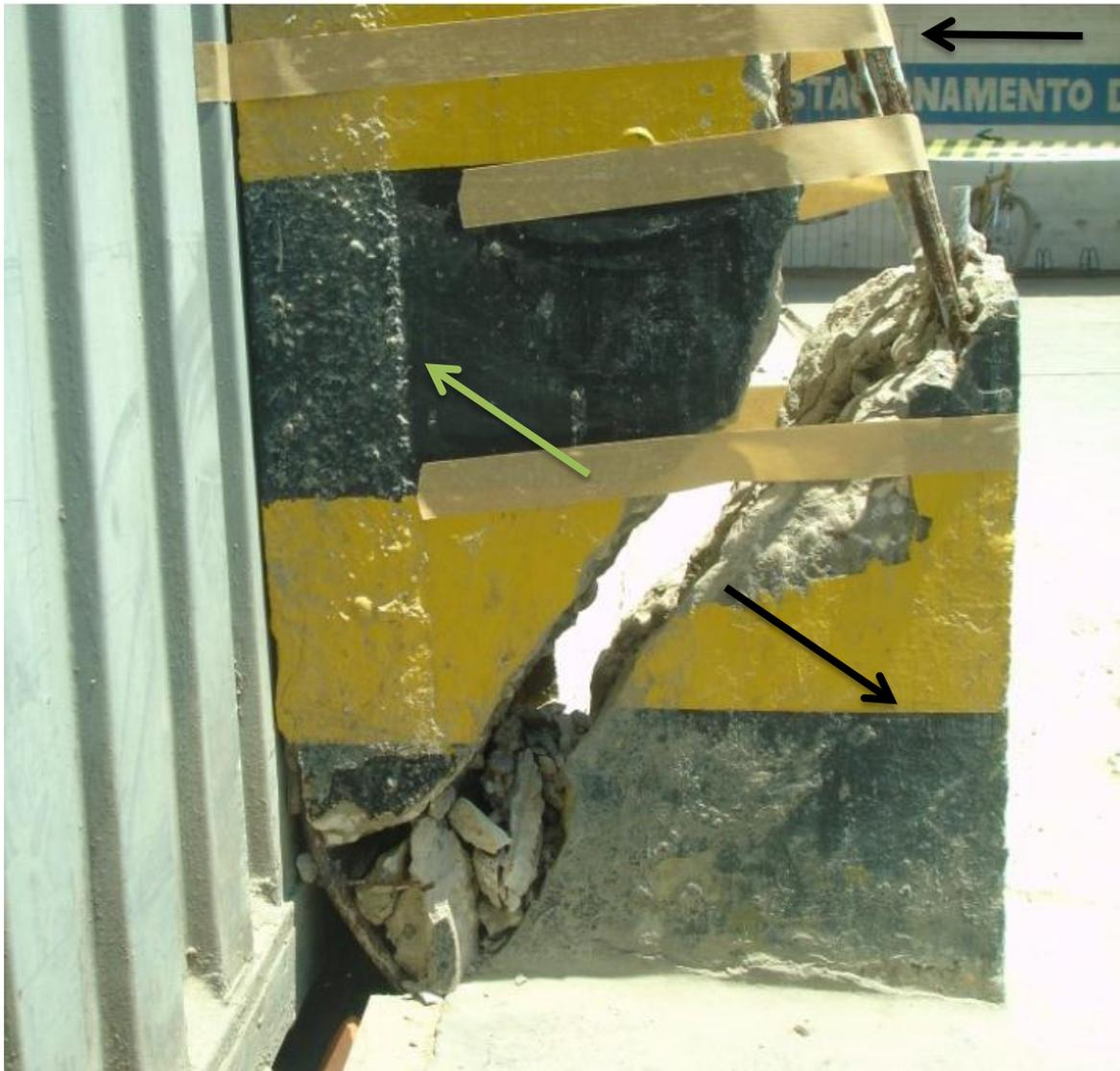
**Figura 2** – Detalhe da ruptura: as fitas adesivas indicam, de forma aproximada, onde estavam os estribos que sofreram ruptura em decorrência do impacto; as setas, perpendiculares à superfície de ruptura ilustram a direção provável das tensões de tração.
