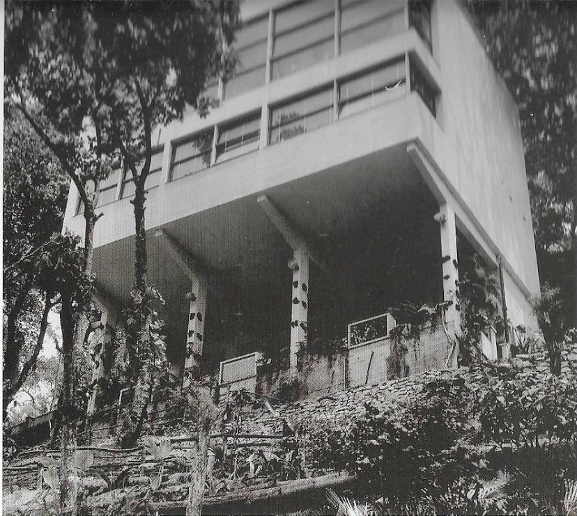
Álvaro Vital Brasil, Residência Álvaro Vital Brasil, Rio de Janeiro, 1940. Elevada em pilotis , a casa foi adaptada ao terreno evitando a necessidade de desmatar a vegetação circundante (acima, à esquerda e corte, no topo à direita). A sala de estar possui vistas para as montanhas e para a baía de Guanabara (acima, à direita).
