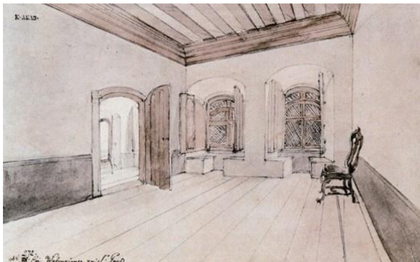
Imagem 59: Interior de uma residência. Observar a espessura da parede de “taipa de pilão” ( pisè ), as “conversadeiras” ao longo das janelas, protegida pela rótula (treliça) de madeira. Desenho de Thomas Ender, “Uma sala de estar em São Paulo”, 1817, lápis aquarelado. Fonte: kupferstichkabinett der Akademie der bildenden künste , Viena, Áustria. Em LAGO, 2003, p.36.
