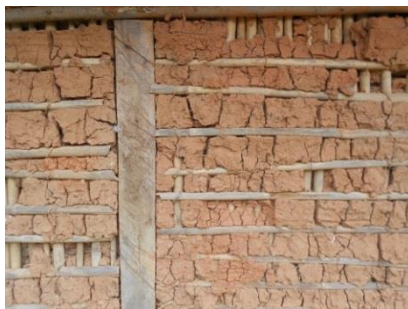
Imagem 57: Detalhe de uma parede de taipa-de-mão ou pau-a-pique. Foto da autora, Joanópolis, 2013.
