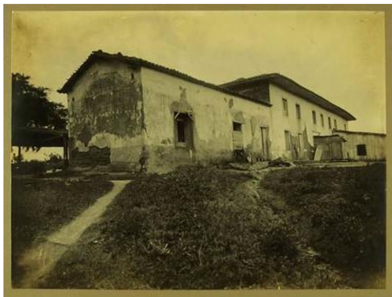
Imagem 42: Mosteiro de Sant’Anna, em 1910, observar a parede de taipa de pilão. Fonte: BMA, álbum Washington Luiz, vol.1, 1862-1900-16.
