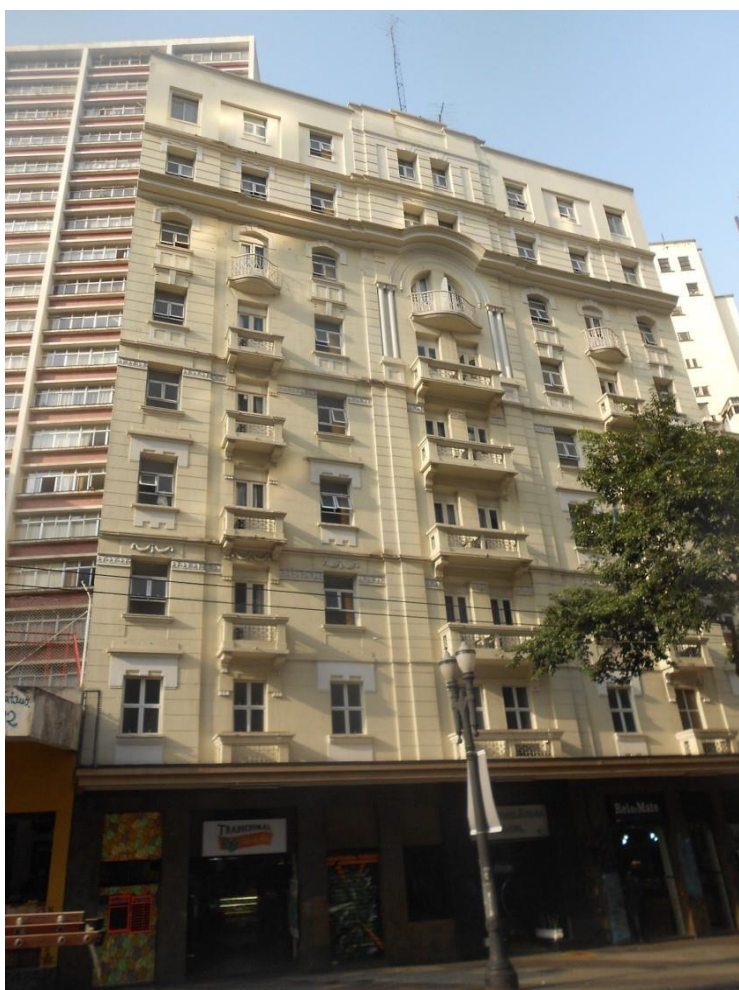
Imagem 383: Fachada principal. Foto da autora, 2015.
