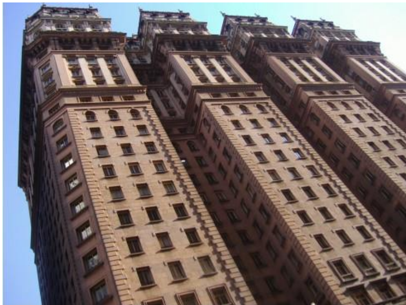
Imagem 429: Detalhe da fachada do "Prédio Martinelli". Foto tirada pela autora em 2006.
