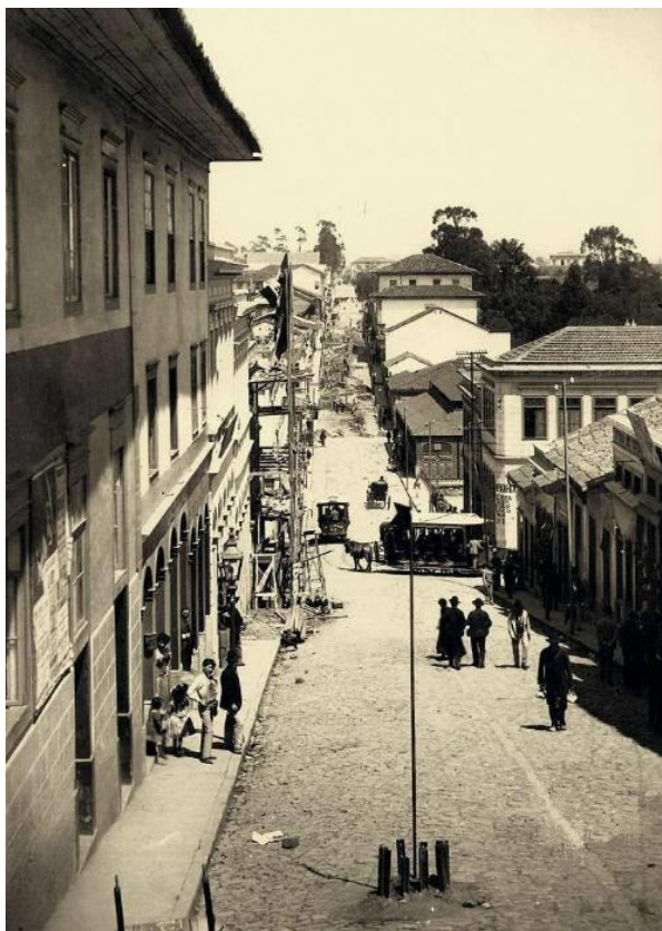
Imagem 458: Vista da ladeira e Rua São João, à direita no alto da ladeira o sobrado, residência da família Souza Barros, c.1890. Foto de Marc Ferrez. Fonte: IMS, p.74.
