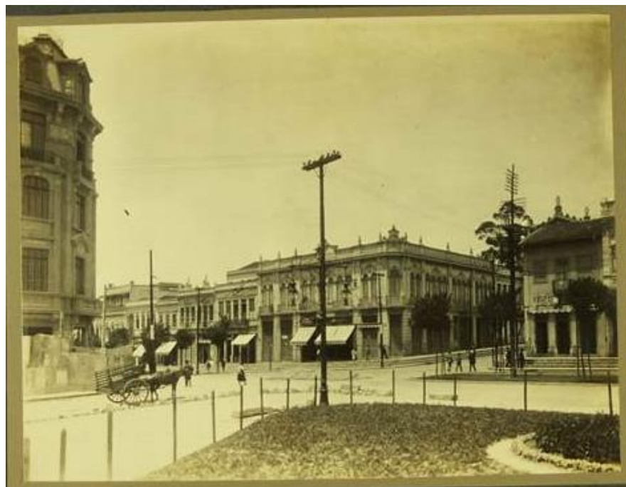
Imagem 187 e Imagem 188: Vista da Rua e depois Avenida São João, foto feita no Largo Paissandu para a Rua Conselheiro Crispiniano. 1910 e 1916, observar na segunda imagem à esquerda o Edifício Cotonifício Paulista. Fonte: BMA, álbum Washington Luiz, vol.1, 1862-1900-16.
