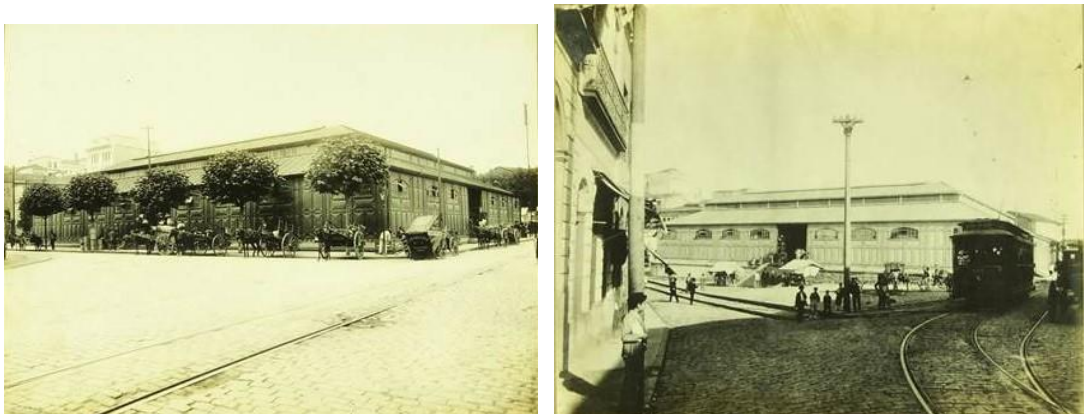
Imagem 102: Mercado São João em estrutura metálica, 1908. Fonte: BMA, álbum Washington Luiz, vol.2, 1862-1900-16.
