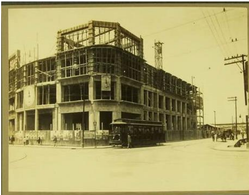
Imagem 236: Prédio do Casino Antarctica em construção, 1916. Fonte: BMA, álbum Washington Luiz, vol.1, 1862-1900-16.
