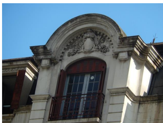
Imagem 381: Detalhe superior da fachada. Foto da autora, 2016.
