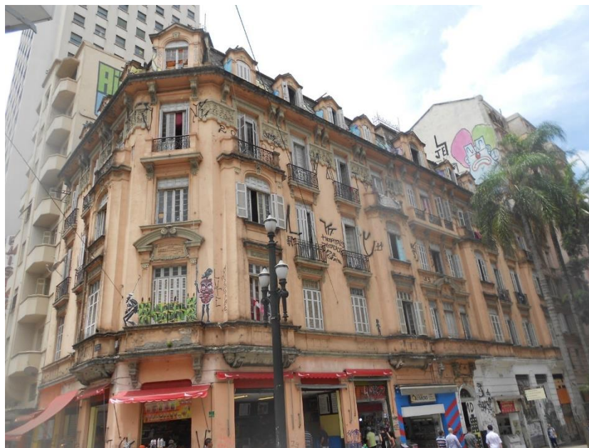
Imagem 259: Fachada do edifício “Cotonifício Paulista”. Foto da autora, 2015.
