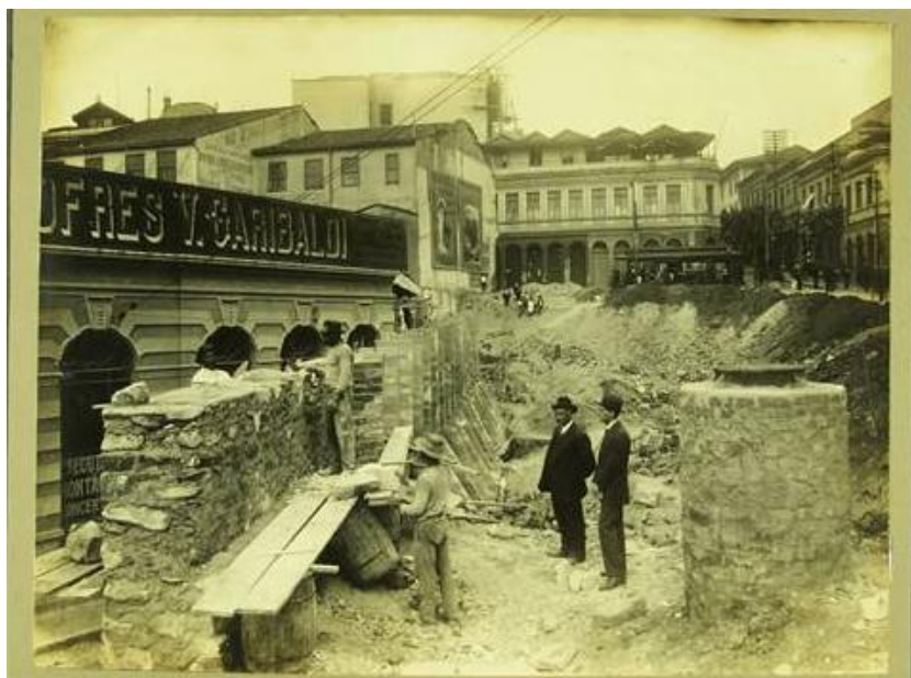
Imagem 95: Vista do canteiro de obras durante o alargamento da Ladeira São João, em 1913. BMA, álbum Washington Luiz, vol.2, 1862-1900-16.
