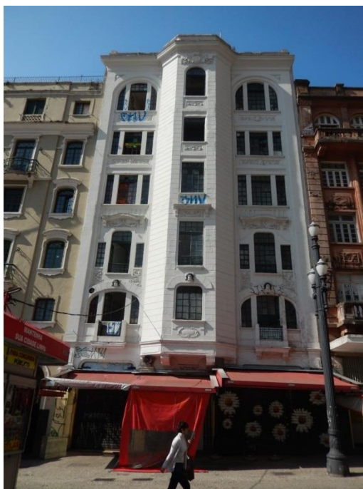
Imagem 352: Fachada principal. Foto da autora, 2016.
