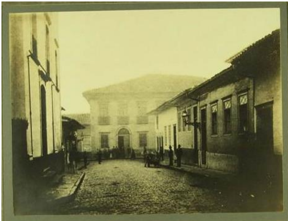
Imagem 28: Vista da casa da Baronesa, foto tomada da Rua Direita, a ser demolida para abertura do Viaduto do Chá, 1862. Fonte: BMA, álbum Washington Luiz, vol.2, 1862-1910-16.
