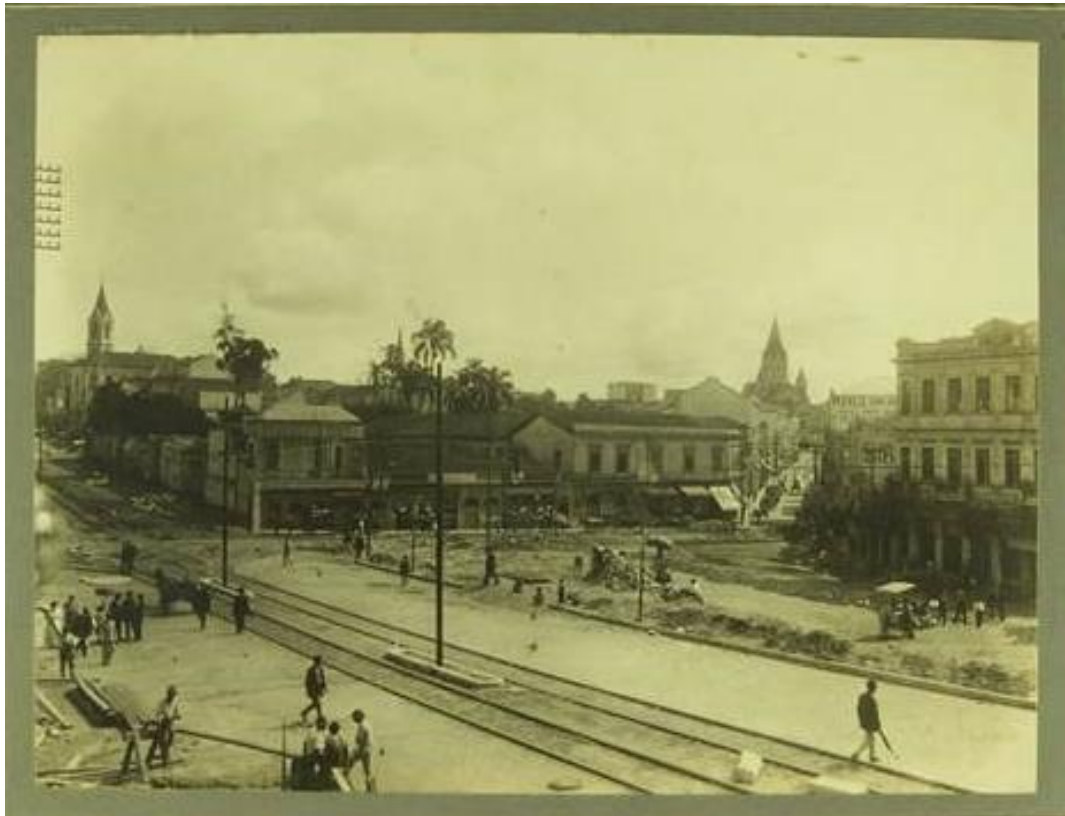
Imagem 110: Obras de alargamento da Rua São João, em 1914. Vê-se o local onde era o Mercado São João, recém demolido. Fonte: BMA, álbum Casa Duprat, vol.1, 1862-1887-1914.
