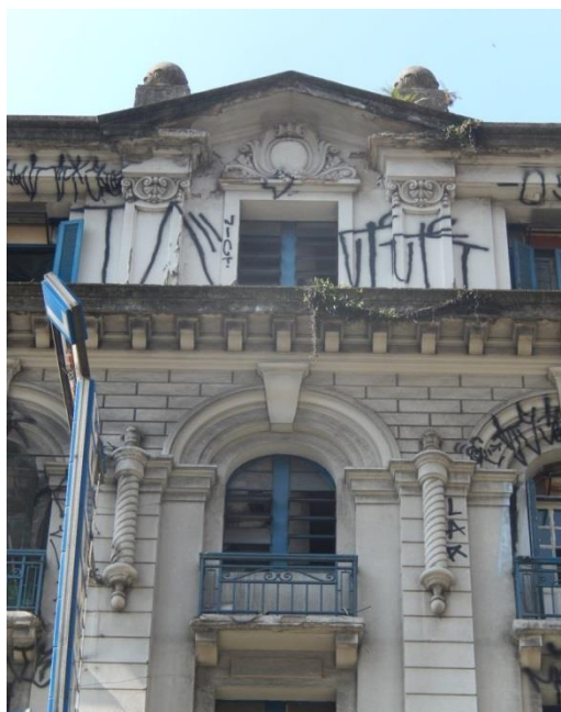
Imagem 287: Detalhe da fachada, ornamento em argamassa. Foto da autora, 2016.
