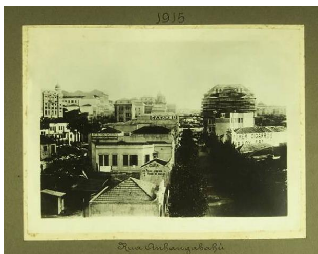
Imagem 246: Vista da Rua Anhangabaú, com o Prédio do Casino Antarctica em obras à direita. Fonte: BMA, álbum Washington Luiz, 1887-1919.
