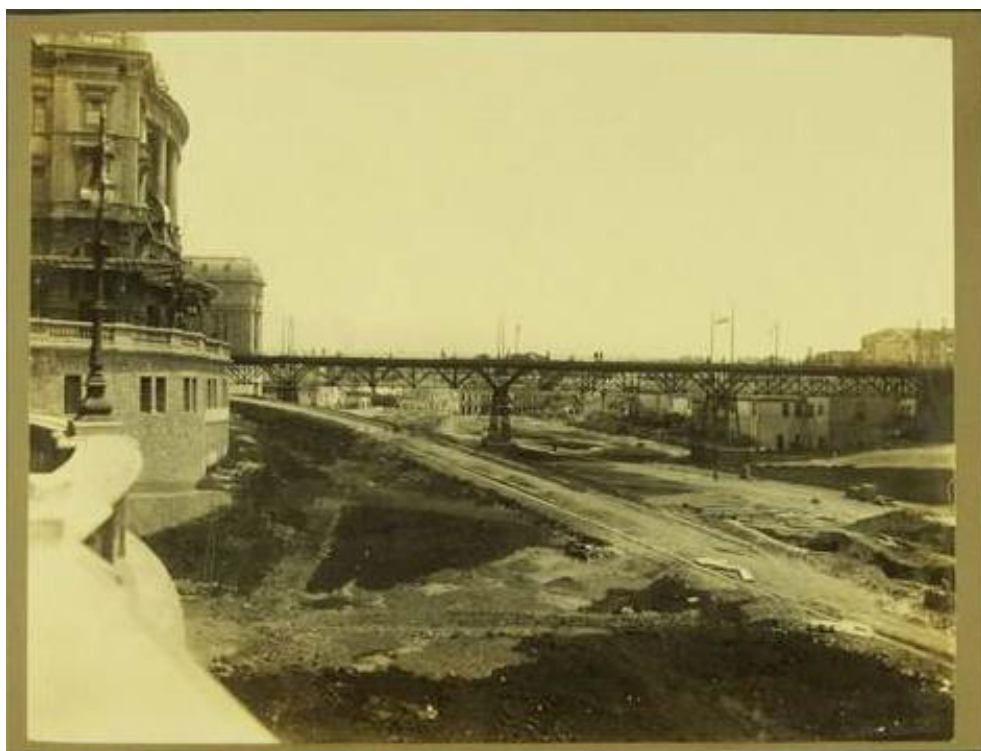
Imagem 39: Vista do Viaduto do Chá em 1916, Parque do Anhangabaú em construção. Fonte: BMA, álbum Washington Luiz, vol.1, 1862-1900-16.
