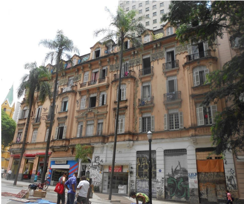
Imagem 261: Fachada do edifício “Cotonificio Paulista”. Foto da autora, 2015.
