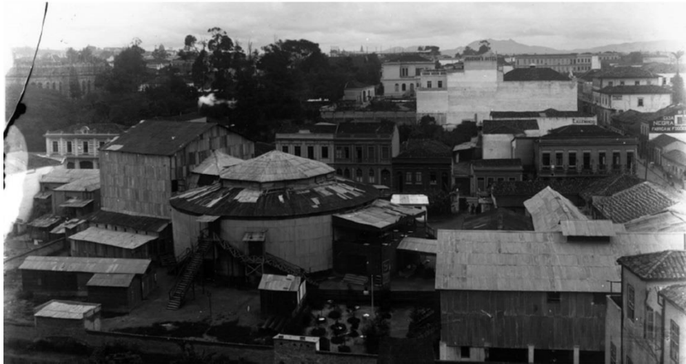
Imagem 124: Vista do Polytheama, o barracão cilíndrico é a plateia, à esquerda o cubo coberto com telha de amianto em duas águas é o palco e camarins. No primeiro plano o barracão com telhado de duas águas é o Theatro Bijou, que faz frente para a Rua São João. Fonte: Acervo Fundação e Energia, em AMADO, 2016, p.105.
