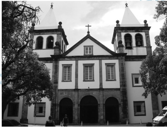
Mosteiro de São Bento (RJ)
