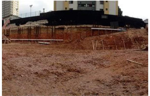
**Figura 5** - Gabarito escalonado devido ao desnível do terreno
