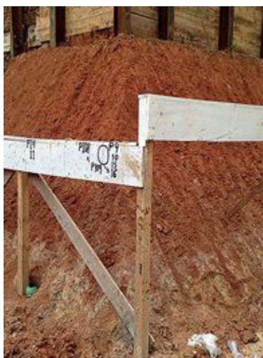
**Figura 2** - Detalhe de canto em gabarito com desnível das tábuas adjacentes
