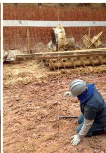
**Figura 4** - Locação de estaca no terreno
