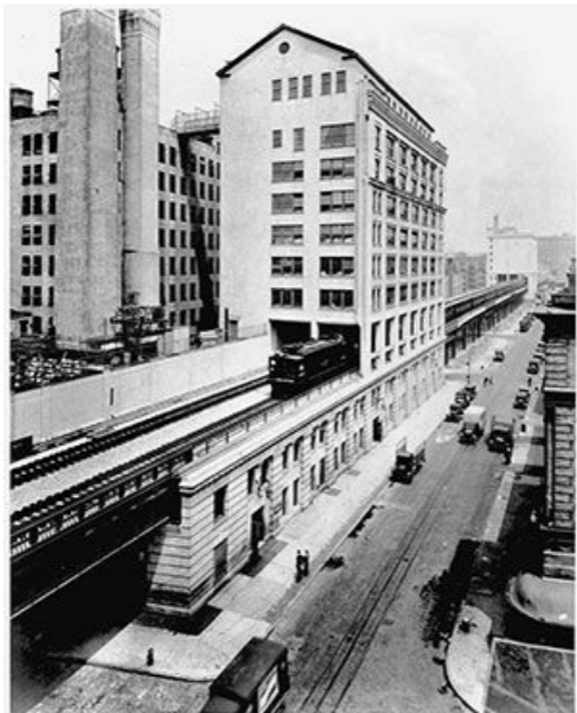
Central dos Laboratórios Bell em West Street, cortada pelos trens da linha superior.
