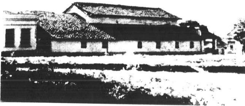
Por volta de 1904 foram registrados pequenos reparos e a inserção de ferro na nave central. Em 1927, segundo o relatório de Mario de Andrade, teria sido executada a última reforma, na qual teriam sido reforçadas as bases erodidas de taipa e reexecutada a pintura interna.
