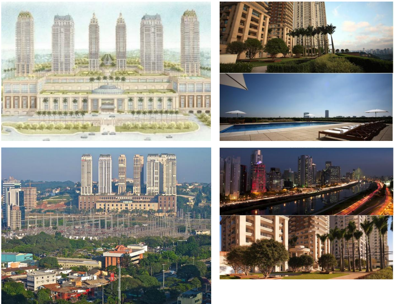
Figura 32 – Imagens do Empreendimento Parque Cidade Jardim
