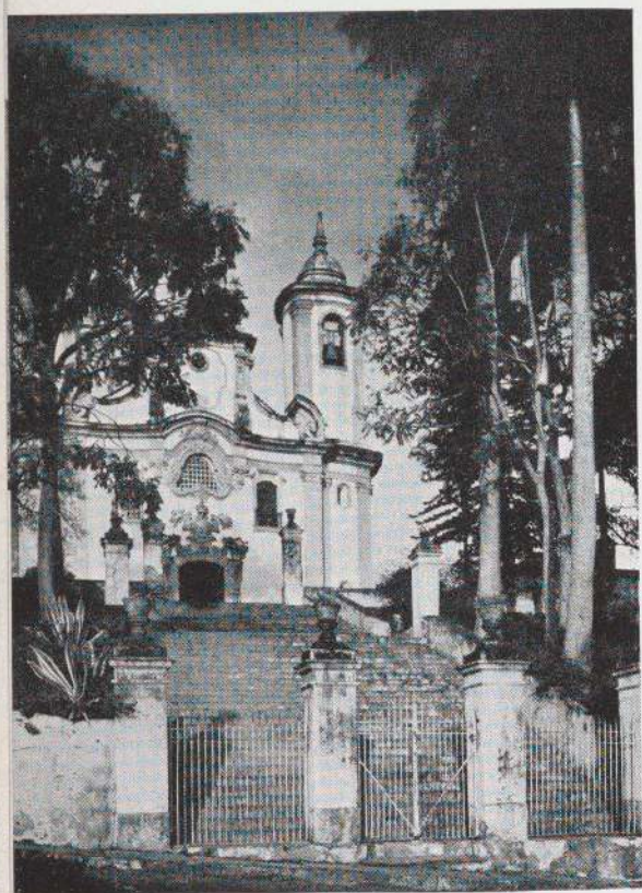
Nossa Senhora do Carmo Ouro Preto, Minas Gerais Manuel Francisco Lisbôa, architect, 1766
