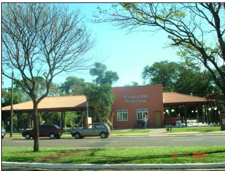
Figura 07: Vista Parcial do Parque das Palmeiras. Foto: BOVO, M. C. 2008.
