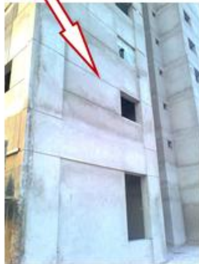
Figura 4 – Foto da fachada do dormitório 2 / final 4, em 20/09/11.
