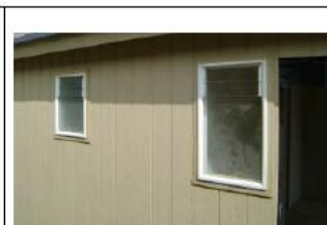
Figura 2: Vista de unidade habitacional com fechamento da face externa das paredes em chapas de OSB tipo SmartSide Panel posicionado na vertical
