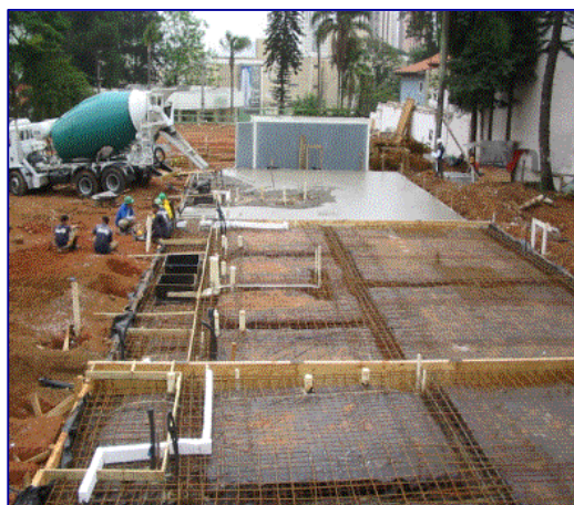
Figura 1 – Concretagem do radier misto.
