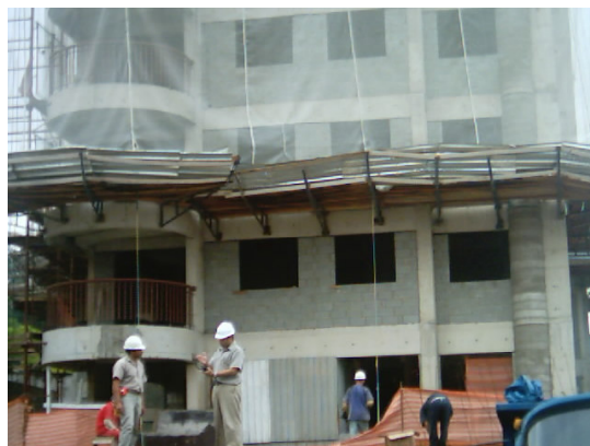
Figura 2 – Vista da fachada de obra que teve o contrato com o subempreiteiro firmado em função da expectativa de produtividade acordada.
