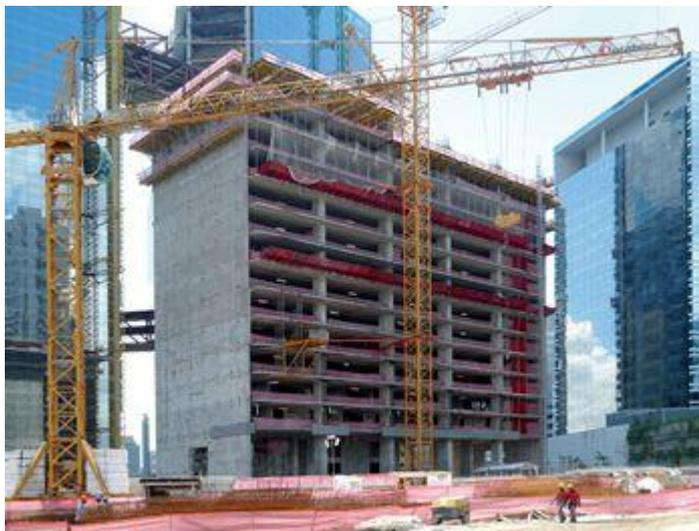
Para a construção de uma torre comercial que compõe o Parque da Cidade, em São Paulo, estão sendo empregadas três guias. A intenção da construtora é evitar gargalos de produção da estrutura, que tem ciclo de seis dias e utiliza lajes alveolares pré-fabricadas
