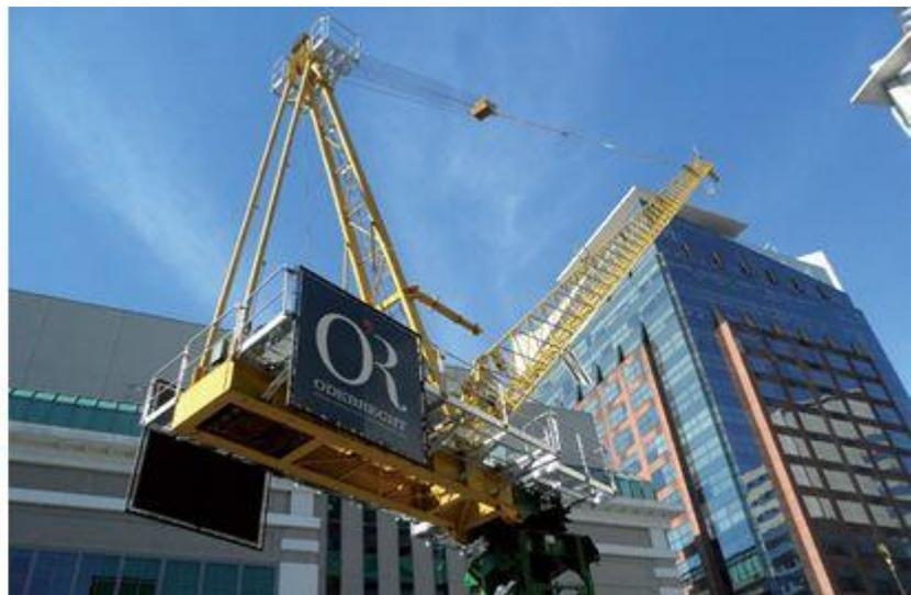
Pórticos rolantes aceleraram a obra e viabilizaram a carga e descarga em terrenos estreitos e com restrição de tráfego. Grua basculante permitiu grandes comprimentos de lança e pequenos giros
