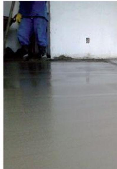
Após executar, com a ajuda de uma empresa especializada, um pavimento-modelo com contrapiso autonivelante, construtora assimilou a técnica de execução e passou a utilizar mão de obra própria no serviço
