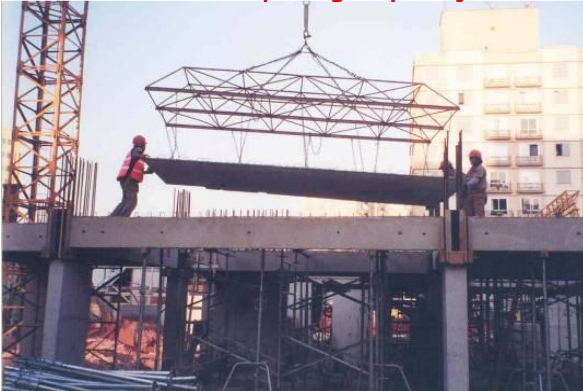
Estrutura metálica e painéis pré fabricados para fachada
