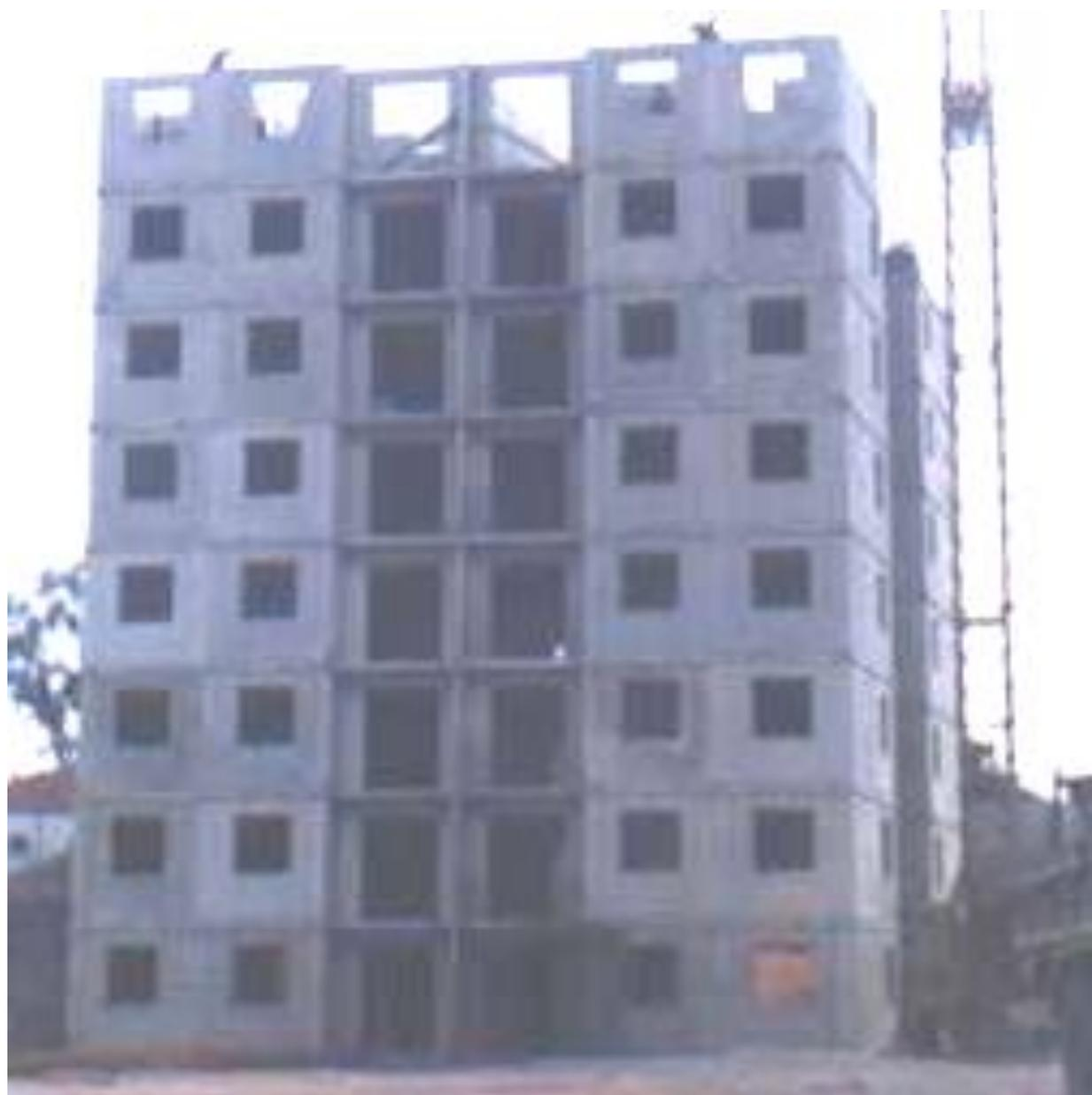
***Painéis pré-fabricados de Concreto Armado com função estrutural-portante
