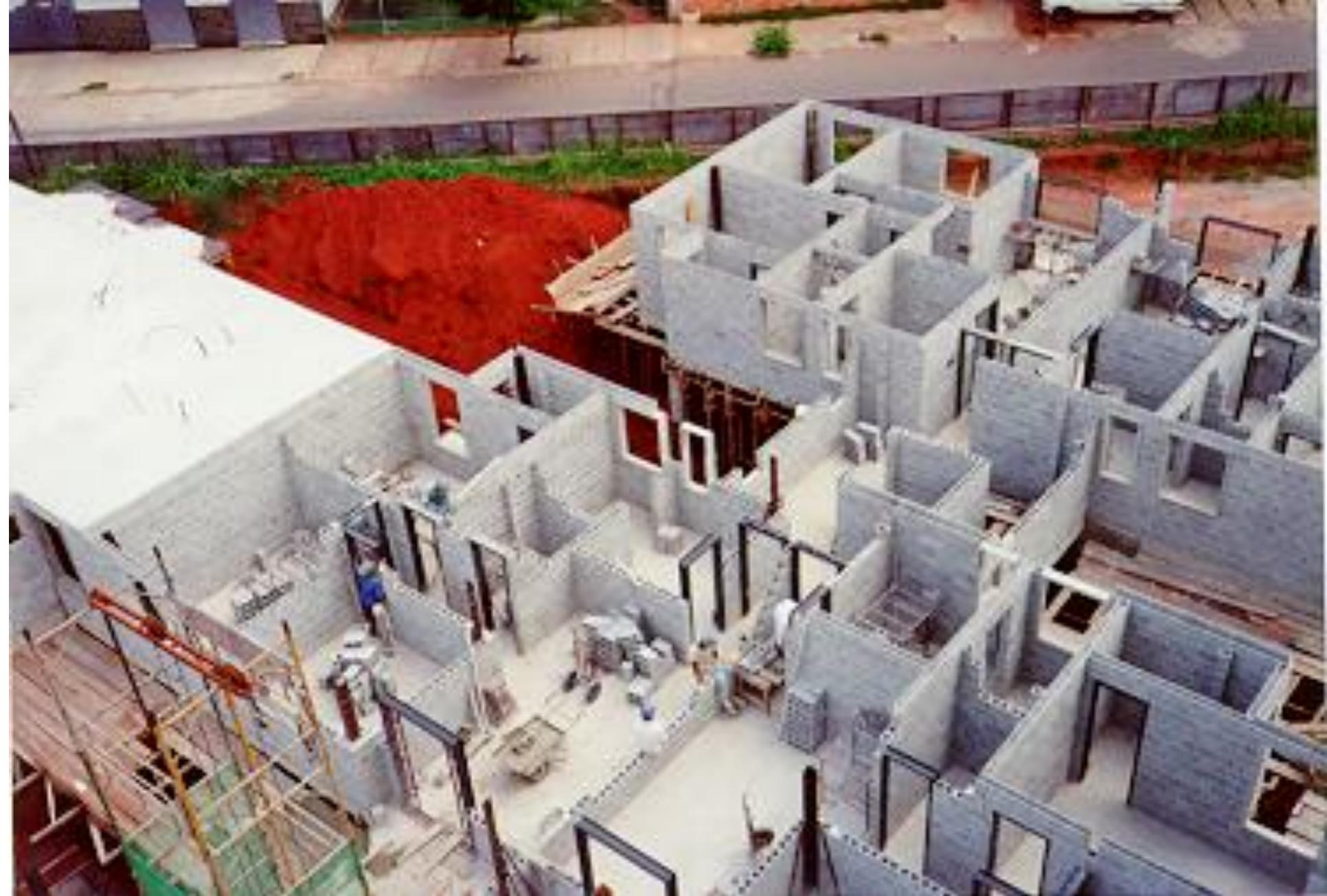
**Alvenaria estrutural não armada**
