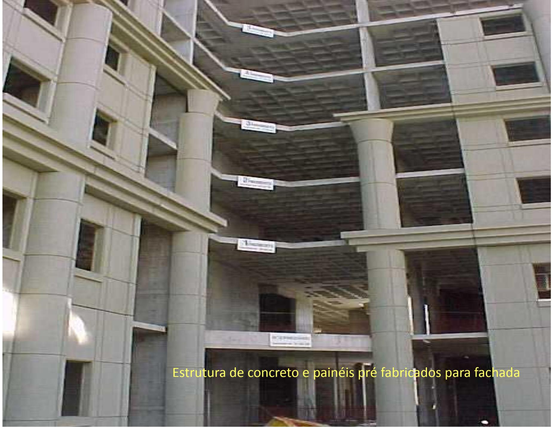
Estrutura de concreto e painéis pré fabricados para fachada
