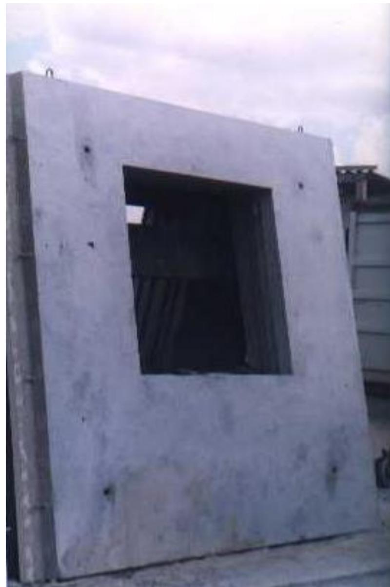
***Painéis pré-fabricados de Concreto Armado com função estrutural-portante - (Sistema Pedreira de Freitas – foto de 1997 - Aracajú)***
