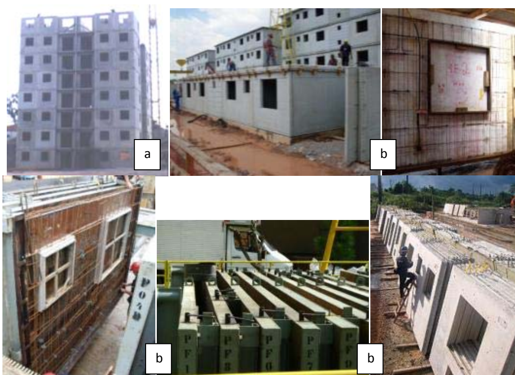
Figura 15 – Sistemas pré-fabricados utilizados para a produção de edifícios habitacionais (a) Sistema PAC utilizado em Aracajú; (b) Sistema empregado na cidade de São Paulo, pela empresa Inpar (Datec 03)(fonte: arquivo Mercia Bottura de Barros).
