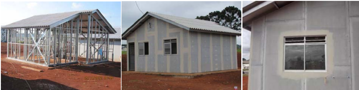
Figura 19 – Sistema Light steel framing para a produção de habitação para uso em casas térreas.
