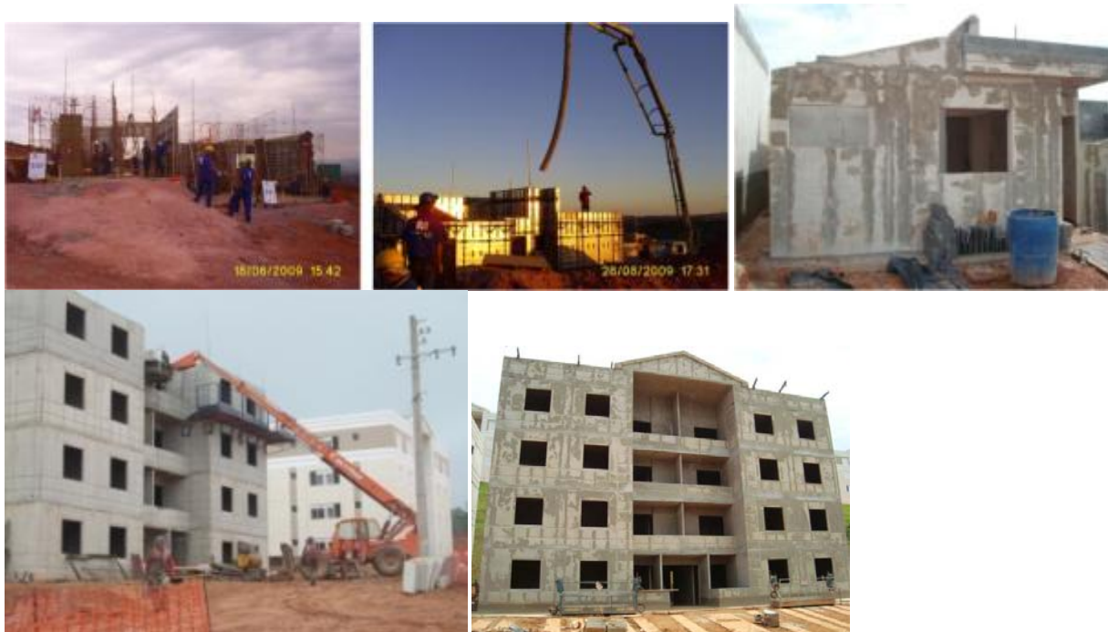
Figura 13 – Sequencia de execução de casas com paredes maciças moldadas no local com fôrmas metálicas e resultado após a desenforma: necessidade de desenvolvimento de concretos com características reológicas adequadas às condições de lançamento e espessura das paredes (fonte: arquivo Mercia Bottura de Barros).
