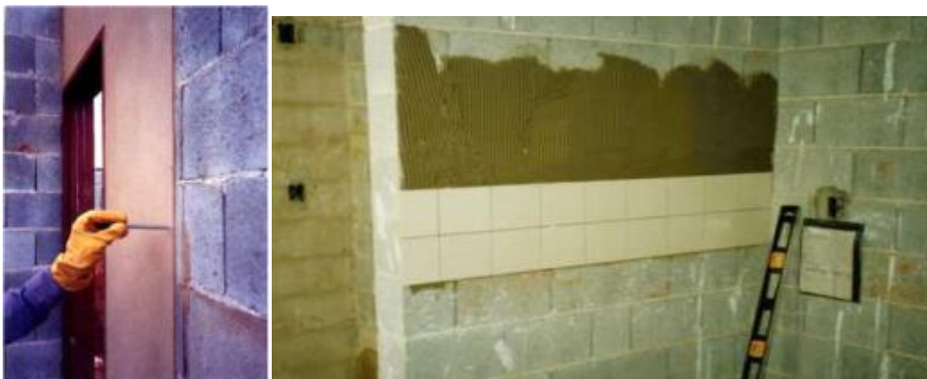
Figura 10 – Revestimentos de pequena espessura aplicados diretamente sobre alvenaria estrutural de blocos de concreto ou cerâmicos (fonte: arquivo Mercia Bottura de Barros).
