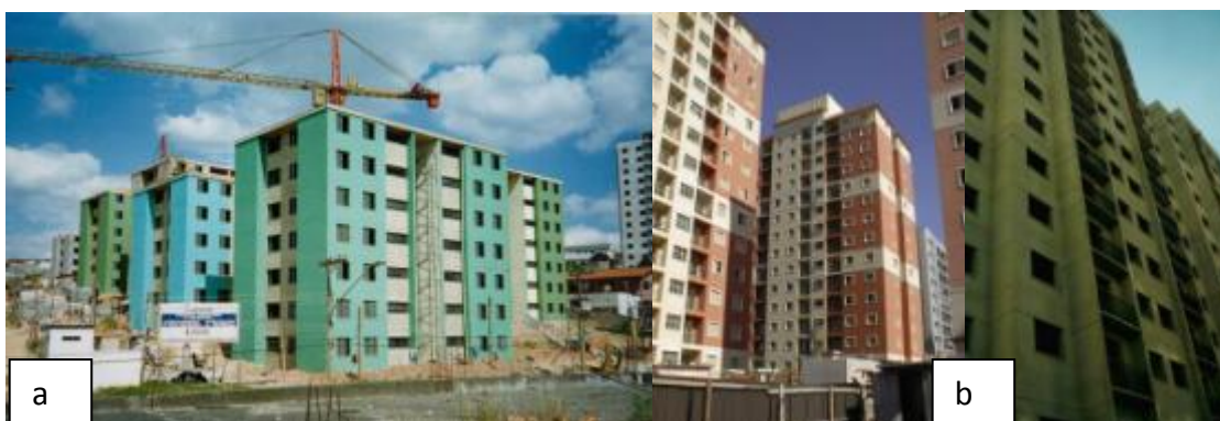
Figura 8 - Edifícios residenciais em alvenaria estrutural (a) padrão econômico; (b) médio padrão , em (Fonte: PCC 2535, 2009)
