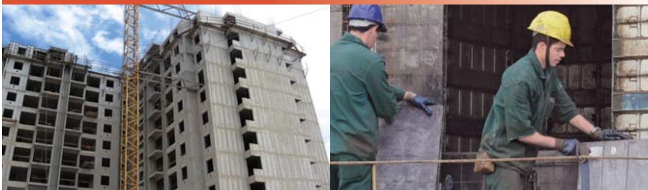
Figura 2 - Paredes de concreto - Fonte: Acervo ABCP
