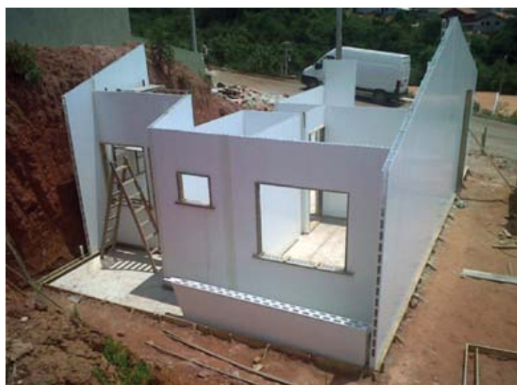
Figura 1 - Casa em Concreto PVC - montagem - Fonte: Global Housing
