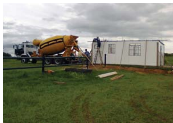
Figura 3 - Concretagem - Fonte: Global Housing
