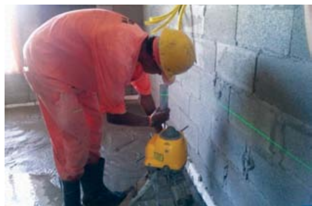
Figura 4 - Transferência de nível Fonte: Concreta (Obra Biarritz Maison Patamares)
