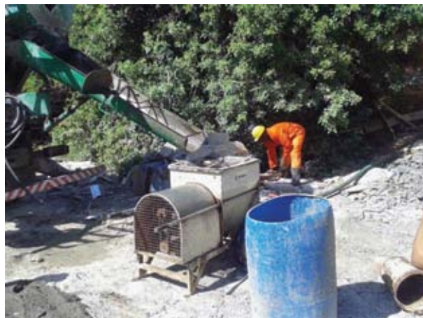
Figura 7 - Bombeamento a partir do térreo direto da betoneira para a bomba - Fonte: Concreta (Obra Biarritz Maison Patamares)
