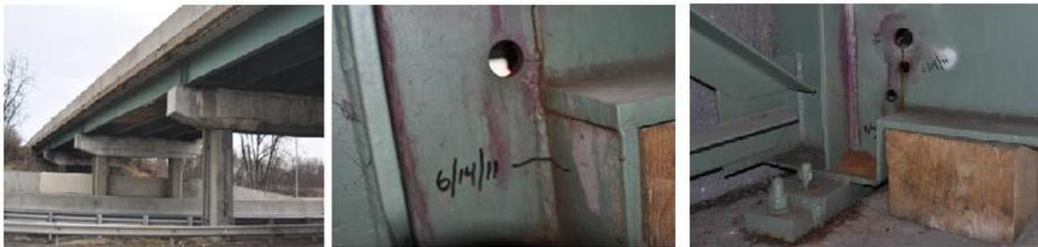
Figura 5. a) Ponte DelDOT 1678-006. b) Fissuração por fadiga na região próxima aos apoios. c) Furos para impedir a progressão das fissuras [15].
