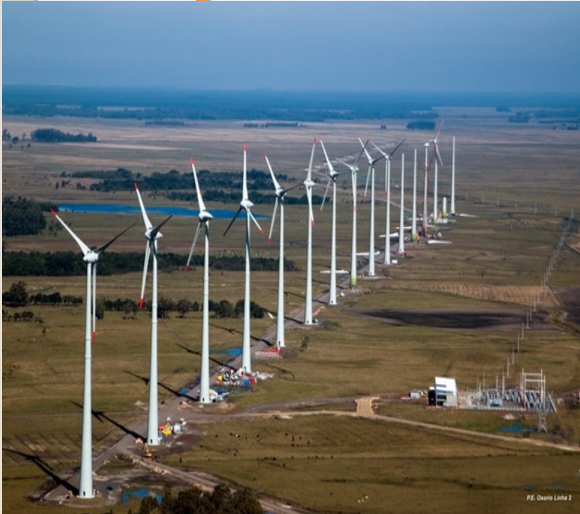
Parque eólico do Osório – Rio Grande do Sul (FONTE: MEIO AMBIENTE).
