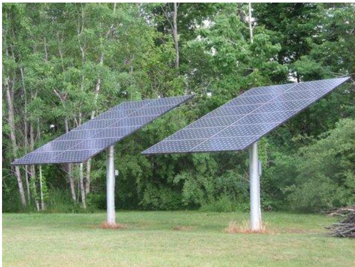
Estruturas com poste único
