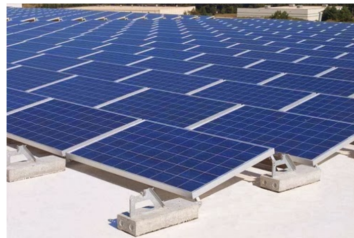
Módulos fixados sem perfuração
