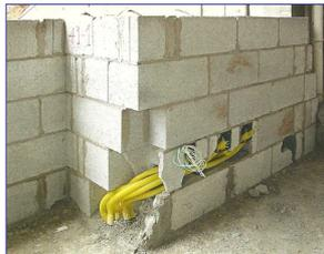
Parede destruída para posicionar pontos da elétrica
