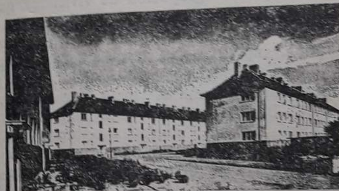
Fig. 17. Edificios de apartamentos, Nuremberg. Fig. 18. Edificios de apartamentos, Braunschweig.
