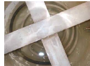
Resistência coberta por água e suporte da cesta
