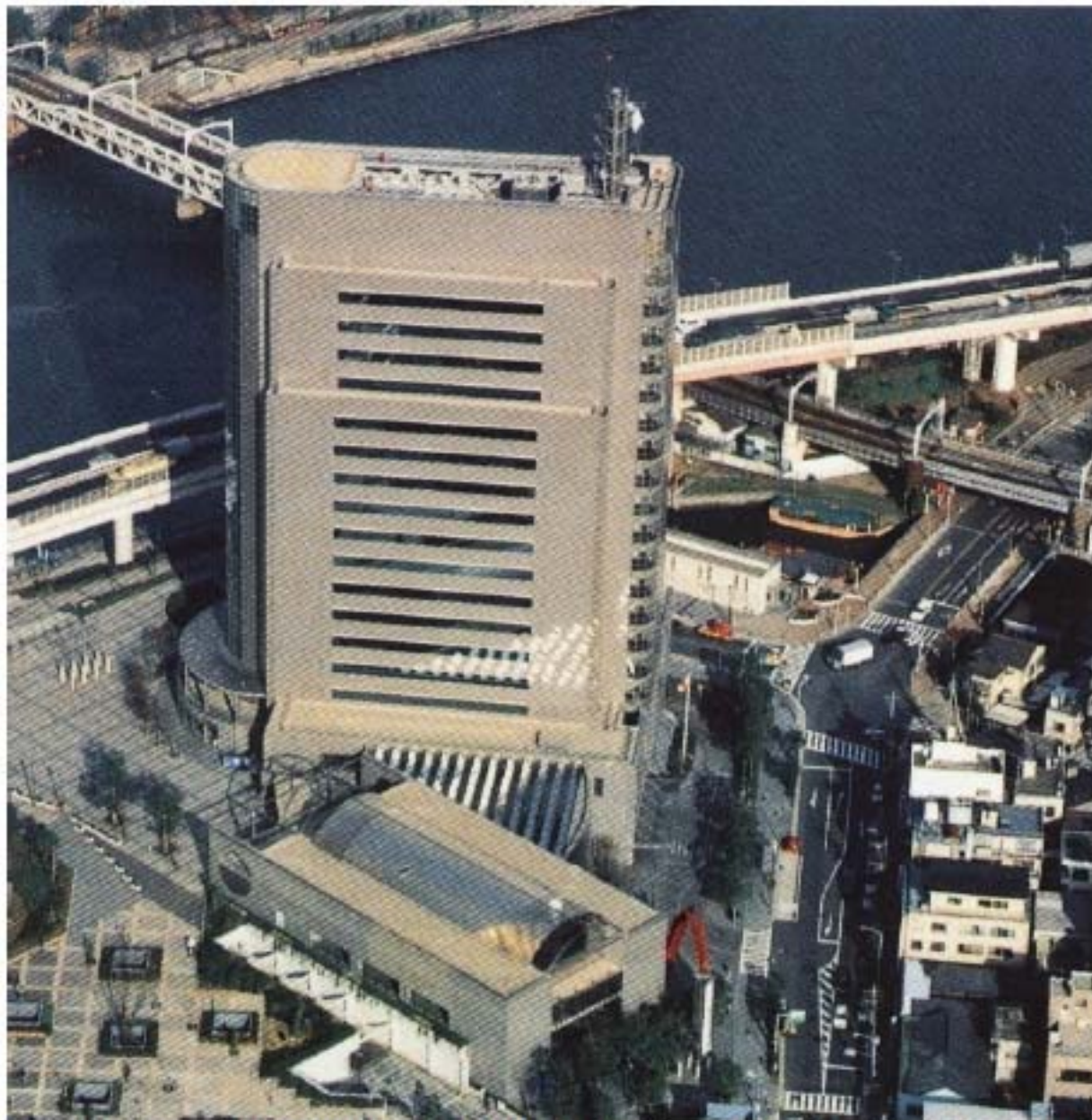
Sede nova da Prefeitura Municipal de Sumida, Região Metropolitana de Tóquio, com sistema de utilização das águas pluviais ( V = 1.000 \text{ m}^3 )
