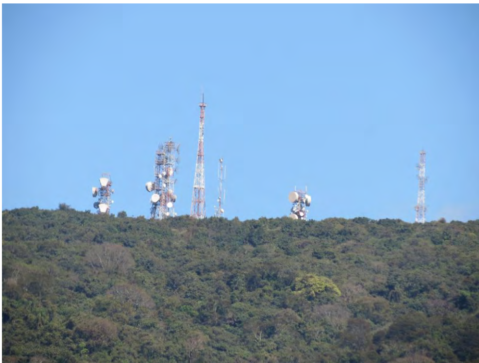
Figura 8.47 - Vista geral das torres.
