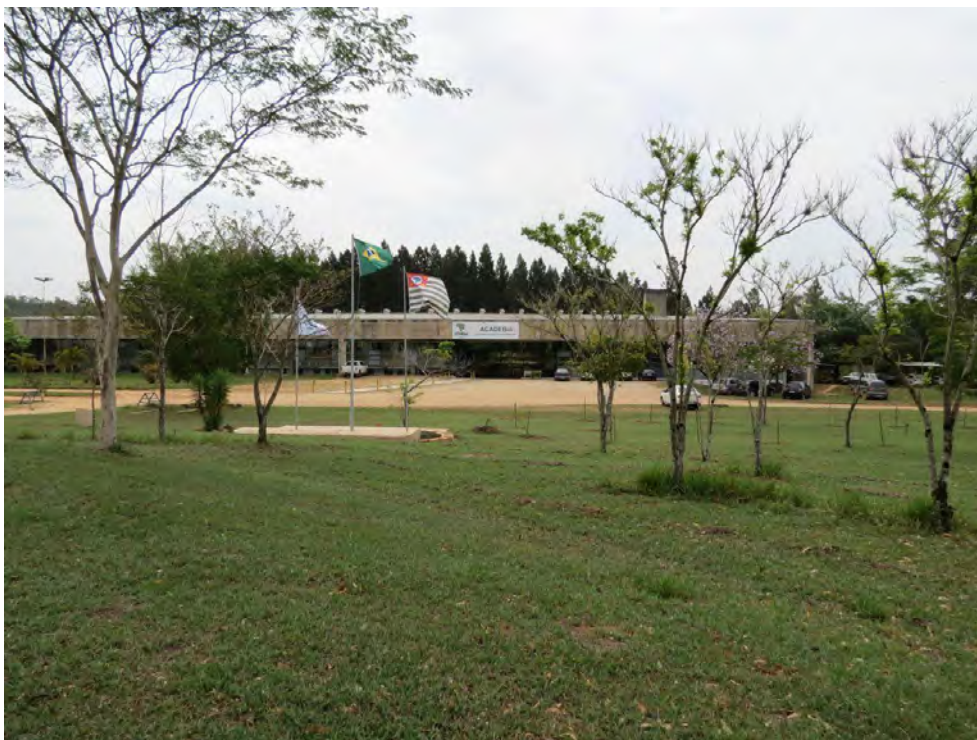
Figura 7.3 - Antiga Sede Administrativa da Flona, atual ACADEBio.
