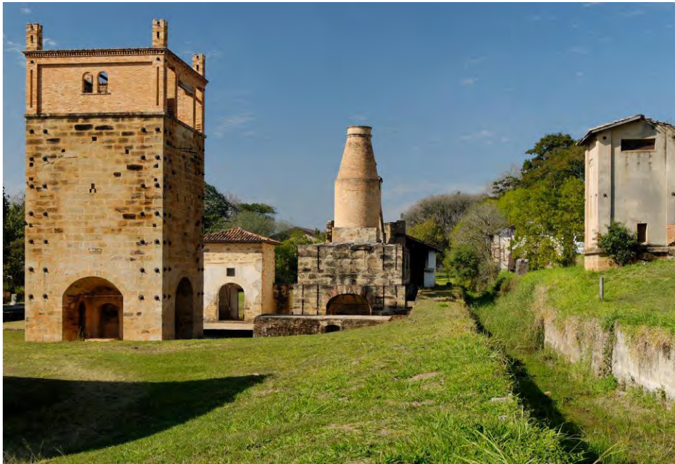
Figura 8.29 - Casa de força a direita do conjunto.
