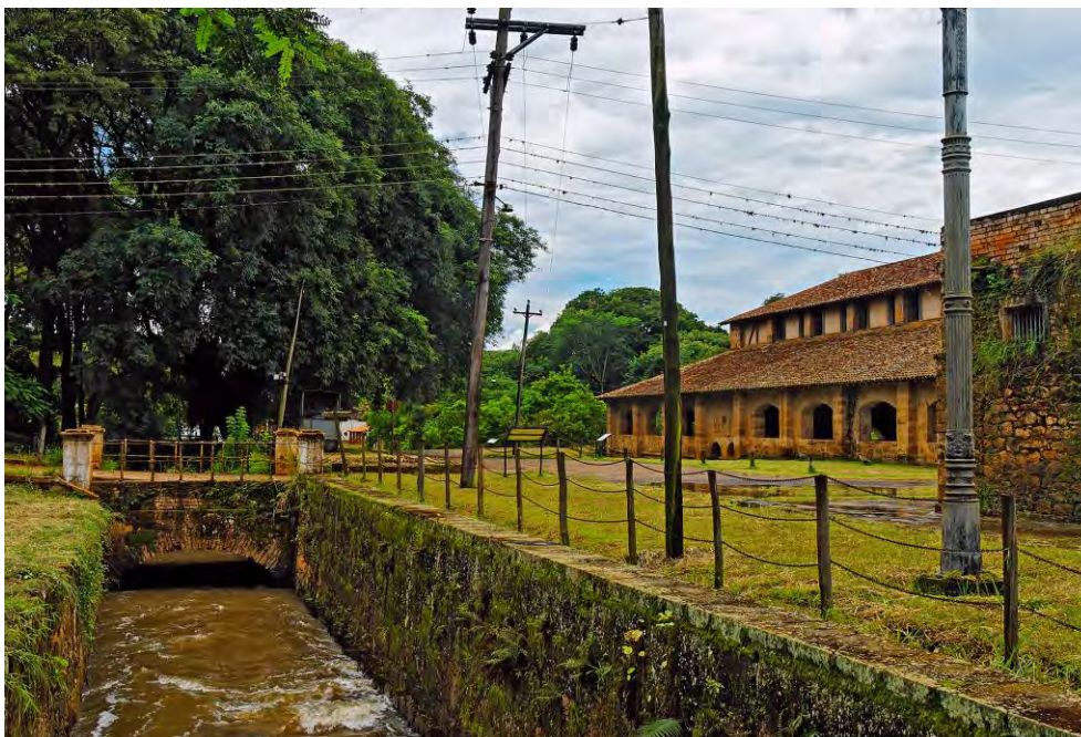
Figura 8.27 - Canal construído para atender aos Fornos Geminados Varnhagen.
