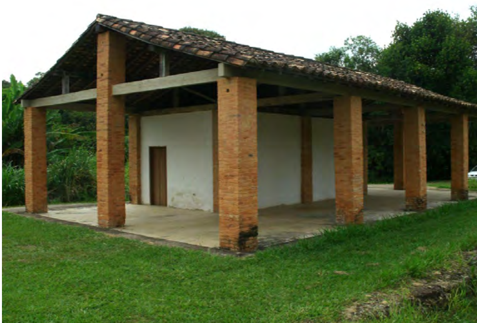
Figura 8.30 – Prédio, após reforma.
